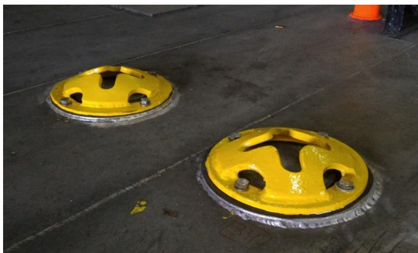
Ilustración nº 51: Pies de elefante reparados
