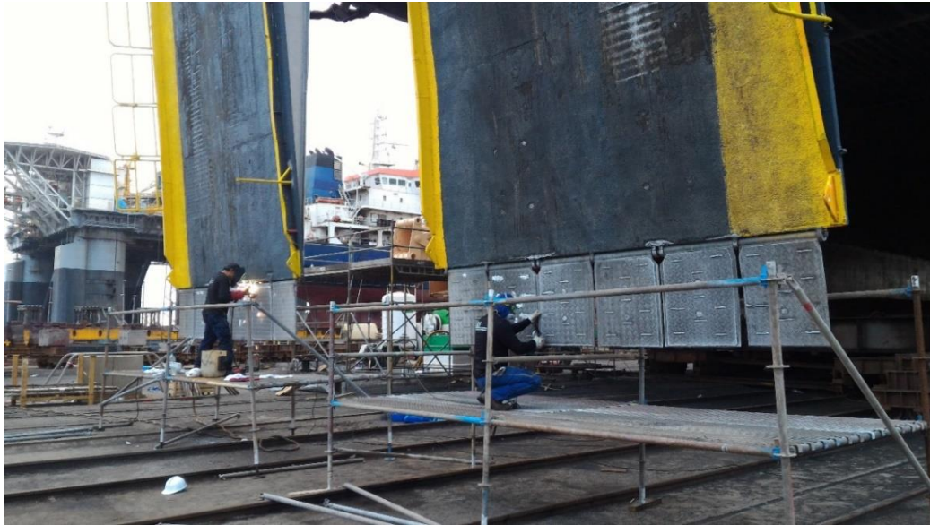
Ilustración nº 38: Trabajos en las uñas de las rampas
