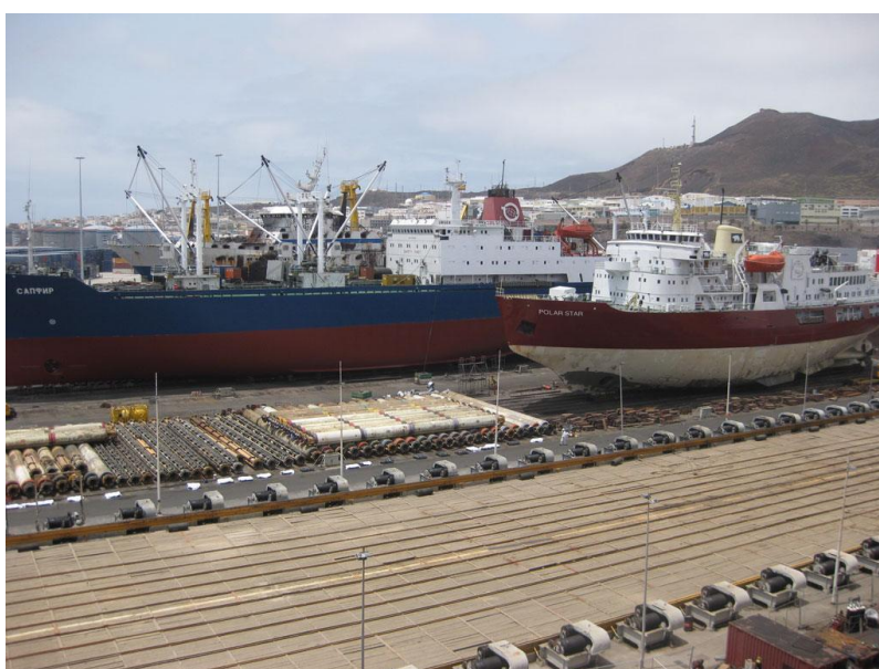
Ilustración nº 27: Plataforma del Syncrolift vista desde su parte superior. Astillero Astican
