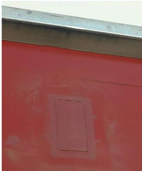
Ilustración nº 49: Proceso de reparación, zona reparada
