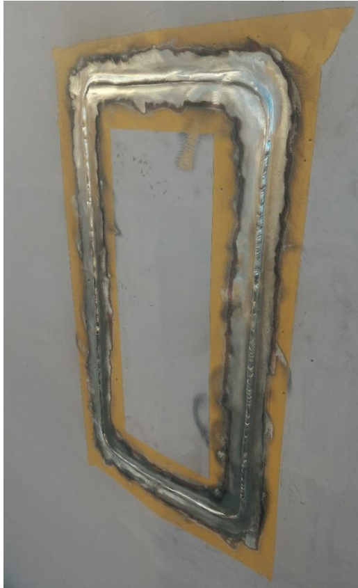
Ilustración nº 48: Proceso de reparación, zona ya soldada
