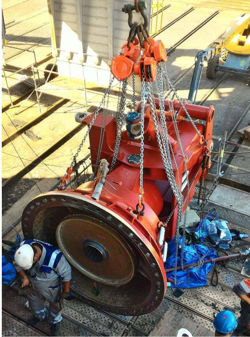
Ilustración nº 56: Proceso de colocación una vez realizado el mantenimiento
