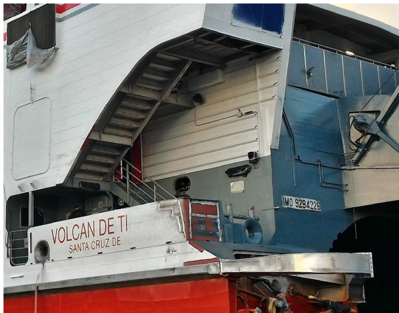
Ilustración nº 41: Reparación de la maniobra de popa babor
