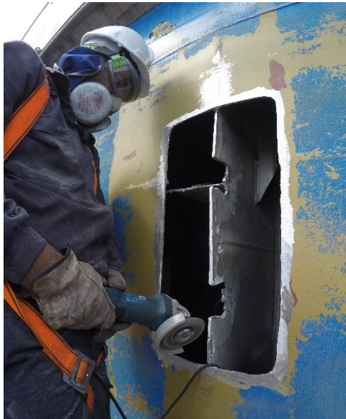
Ilustración nº 46: Proceso de reparación, se corta la zona afectada
