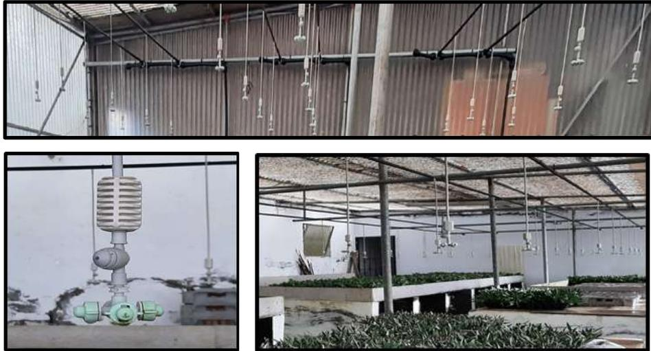
**Imagen 9: Sistema de riego de nebulización en el invernadero de Breña Alta (arriba y derecha) y Colector del sistema de riego en el invernadero (izquierda)**
