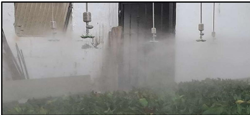
Imagen 17: Sistema nebulización, Mist System, en funcionamiento en el invernadero
