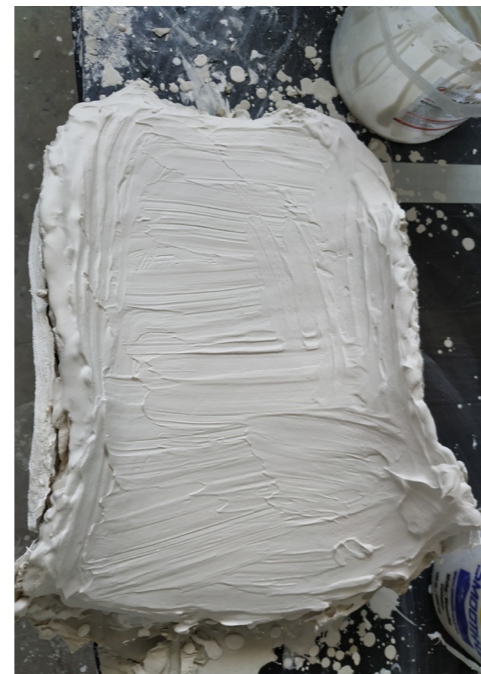
45. Alisado de la escayola y últimas capas de aplicación.
