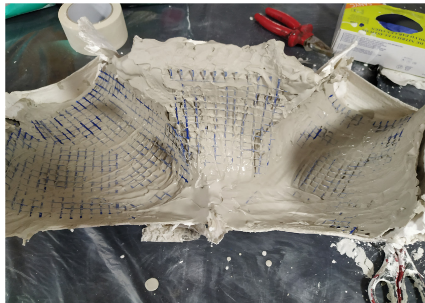
81. Refuerzo de la pieza con tela de encofrado.
