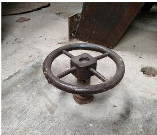
Fig. 9. Detalle de la llave del alviadero. Fuente: propia
