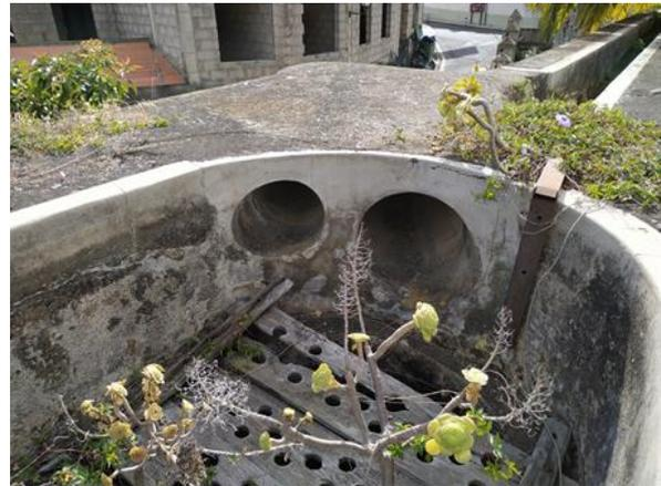
Fig. 2. Detalle de la entrada del agua y del aliviadero. Fuente: propia
