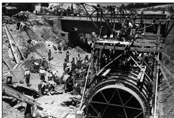
Figura 22. Construcción del Canal del Bajo Guadalquivir.
