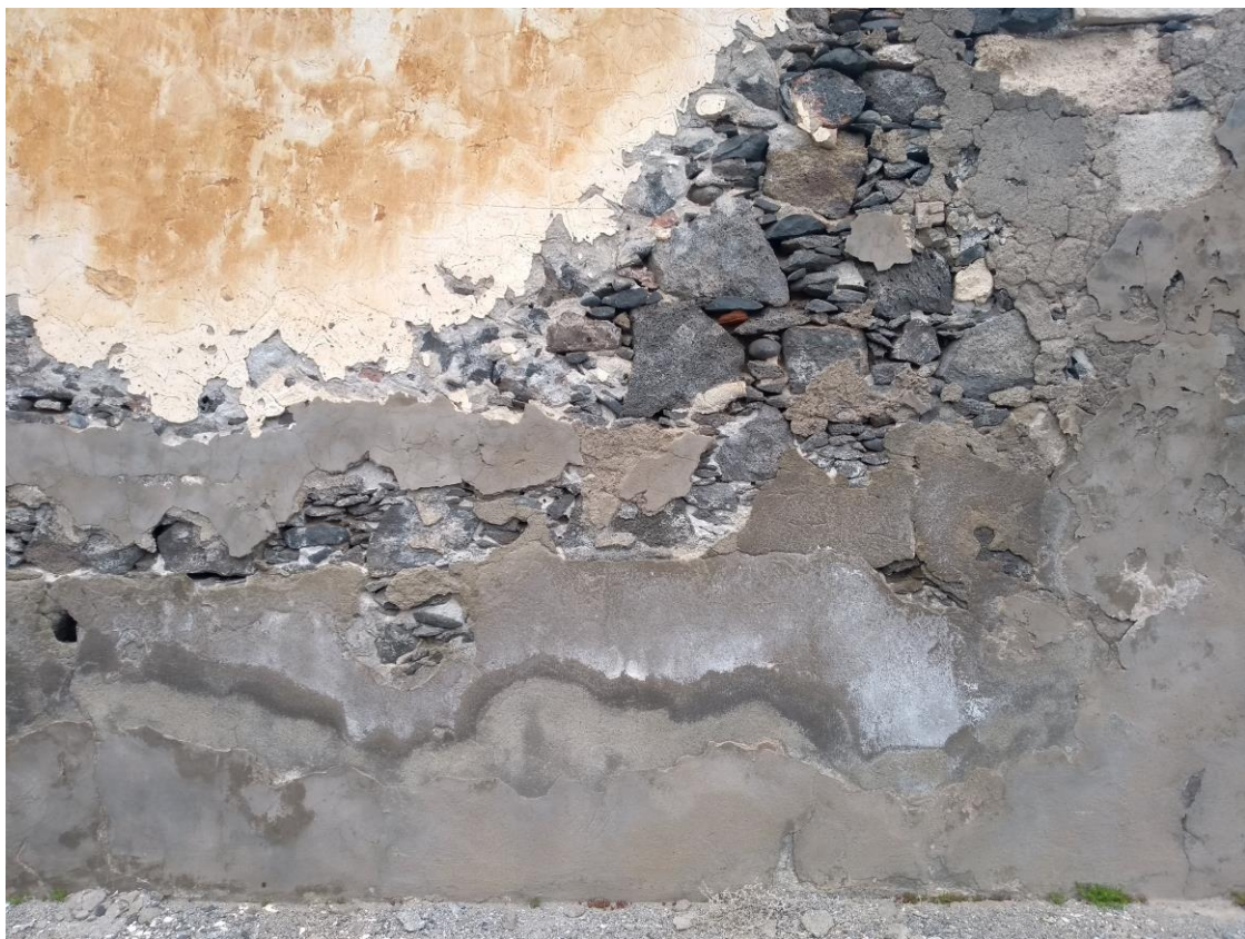
Detalle de la configuración constructiva de los muros de las naves. Foto del autor.
