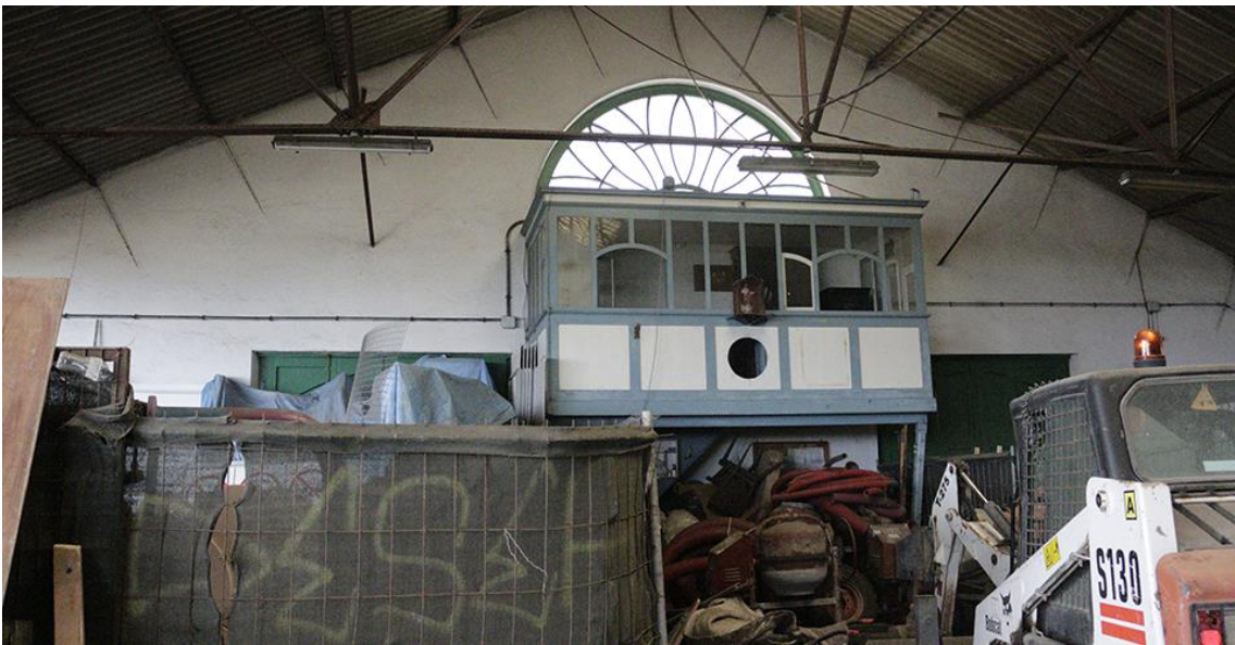
Interior de las naves. Estado actual. 29 de diciembre de 2017. Foto: dautedigital.es
