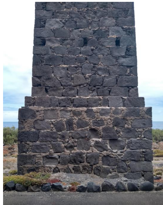
Detalle de la chimenea. Foto del autor.
