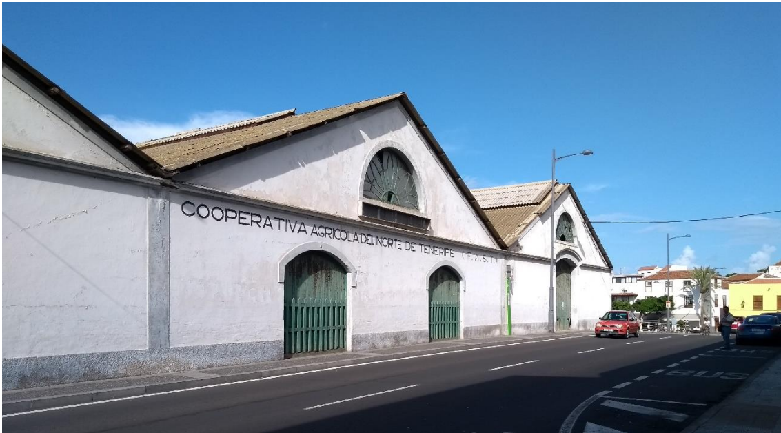
Fachada Principal. Av. Venezuela n°15, Garachico. Fotografía del autor.
