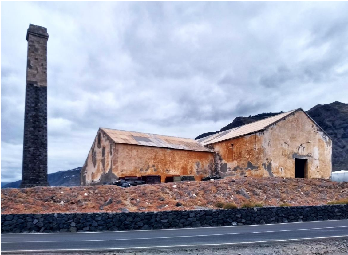
Vista del conjunto en su estado actual. Foto del autor.
