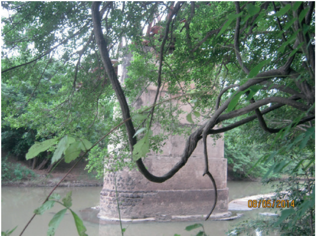
Photo 4: Pile du grand pont Allemand dans OKM
