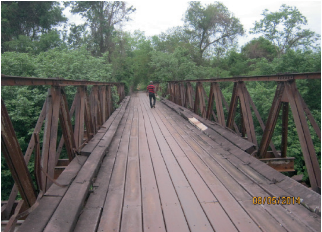
Photo 3: Paysage du tablier du grand pont allemand dans OKM
