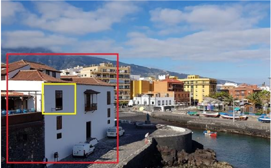
Fig. 5 Vista de la parte trasera de la Casa de la Aduana fotografiada desde el muelle del Puerto de la Cruz. El cuadro rojo delimita la Casa, mientras que el amarillo indica donde se ubica el depósito.
