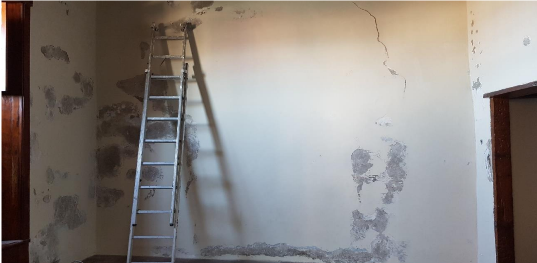
Fig. 18 Representación de la pared que presentaba problemas de humedad durante las reformas de este año.
