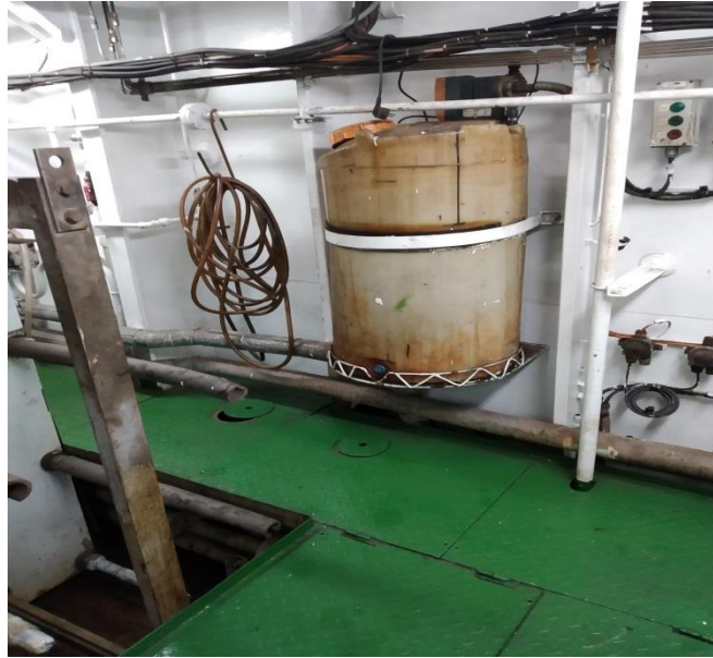
Ilustración 12: Tanque de dosificación química. Elaboración propia.
