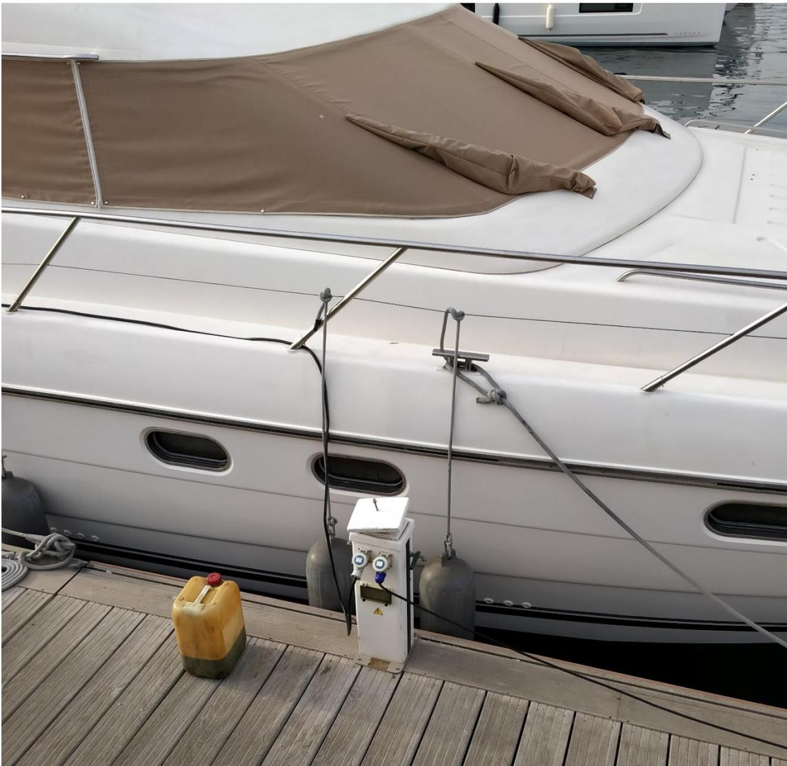
*Figura 4. Conexión eléctrica en la marina para que los barcos se puedan conectar a la red eléctrica*
