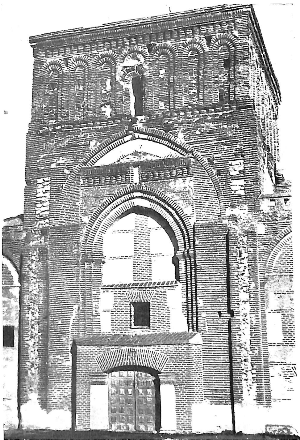
LAM. III.— La Lugareja. Parte central de la fachada. (Foto del S. E. A. A.)
