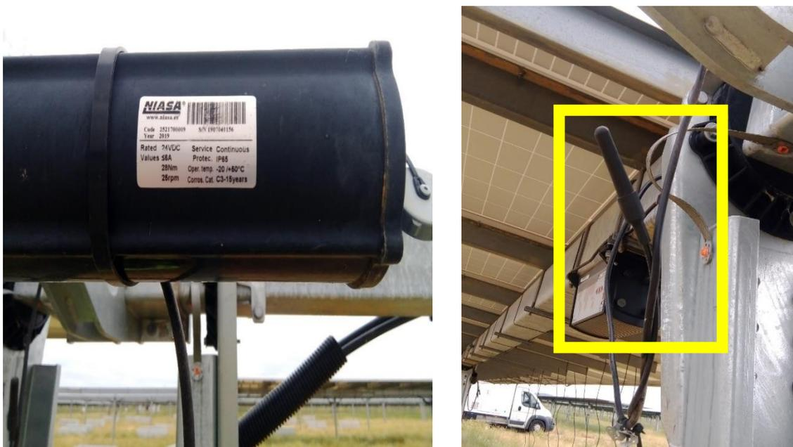
Figura 50. Motor de corriente continua para el desplazamiento de los módulos fotovoltaicos (izquierda). Sensor calibrado para el seguimiento de los módulos fotovoltaicos (derecha). Fuente: propia.
