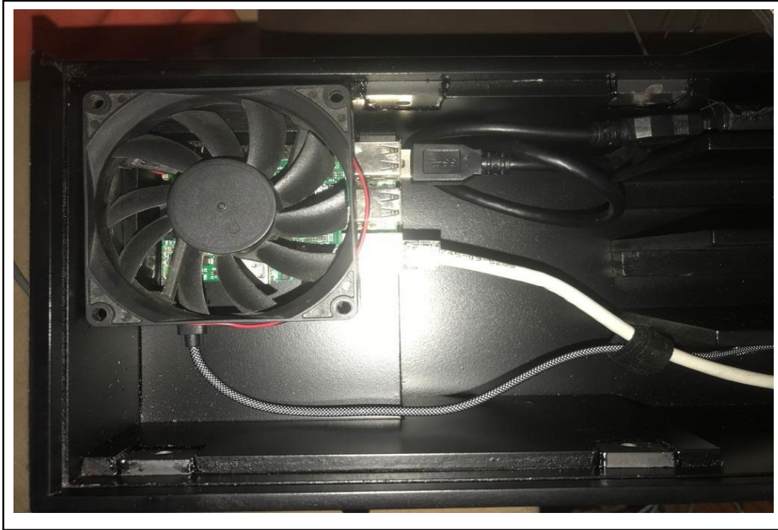
Figura 21. Servidor NAS ubicación final de la Placa y ventilador, (Mera y Herrera 2021)
