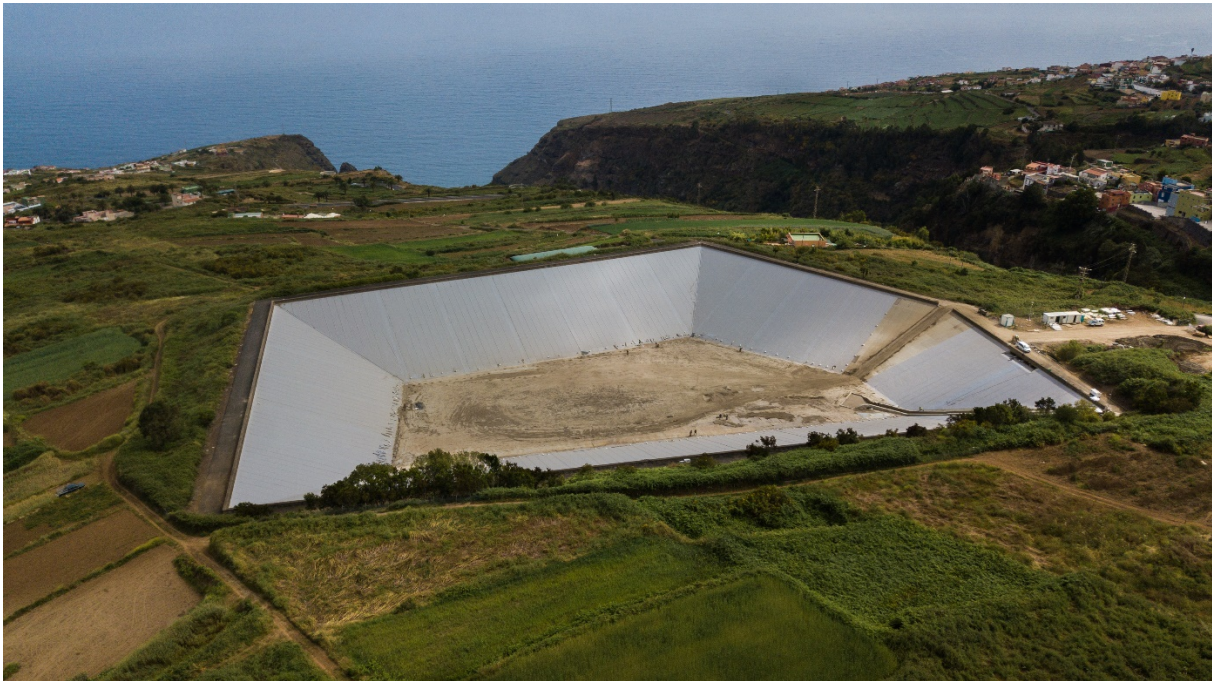
Figura 4. Balsa de Llanos de Mesa durante su re-impermeabilización. Se aprecia como el fondo y parte de los taludes no están aún impermeabilizados.
