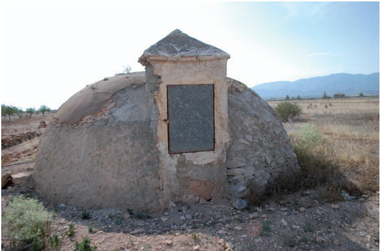
Fig. 2. Aljibe de vaso cilíndrico y cúpula de casquete esférico. Paraje Los Hanghes. Cª de El Escobar a Fuente Álamo
