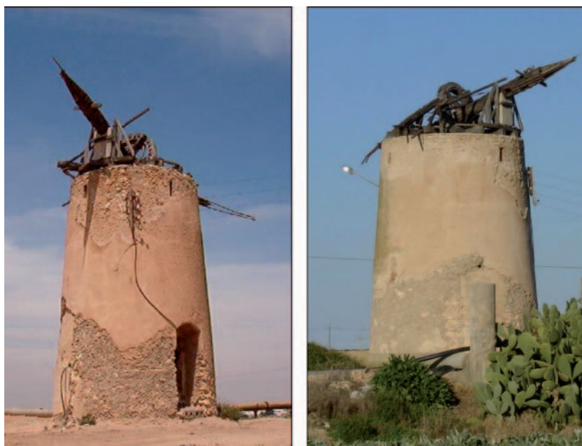
Figura 1. Vistas generales del Molino de Los Roses.
