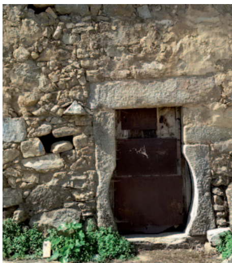
Figura 6. Puerta de una bodega y ventana de ventilación
