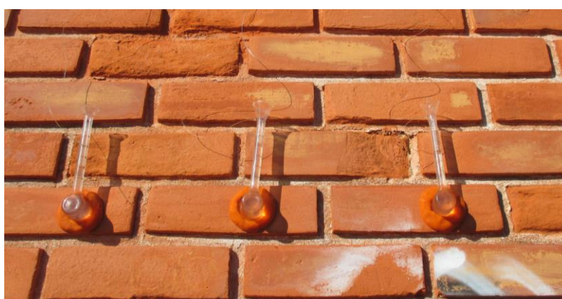
Figura 3.9. Ensaio de absorção de água sob baixa pressão com tubos de Kasten na parede exterior em que foram realizados os biotratamentos in situ em tijolos cerâmicos maciços deteriorados
