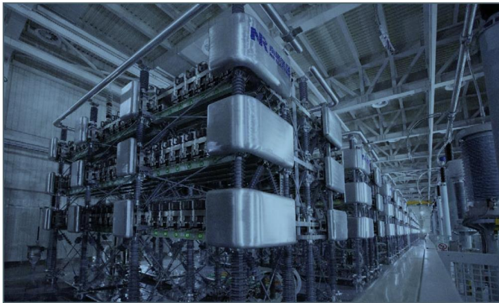
Figura 2.8 - Representação do VSC de um UPFC [31]
