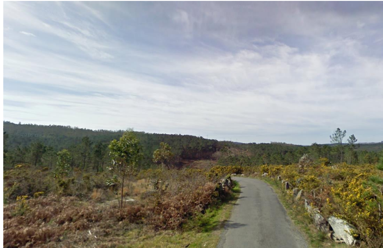
Fotografía 4. Zona de inicio de la variante mediante los ramales de enlace una vez construido el nuevo corredor VG-1.5 (actual traza abierta del corredor)
