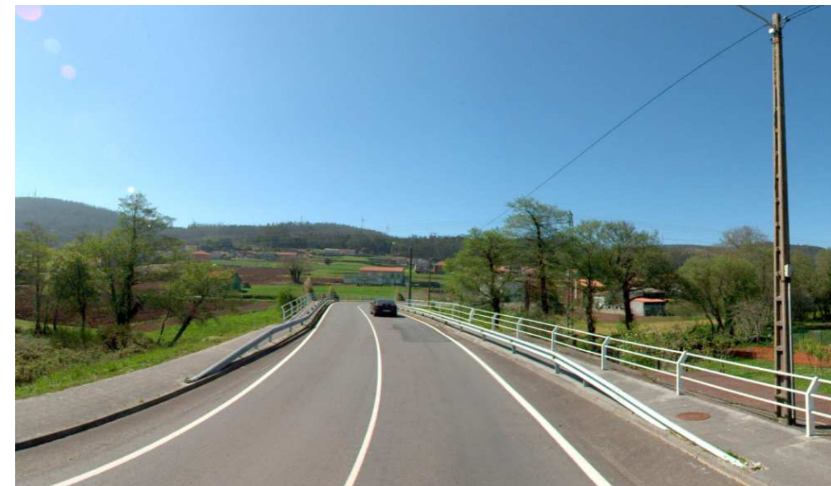
Figura 8: Intersecciones de la AC-432 con el Río de Vimianzo el cual en ocasiones con su desbordamiento interrumpen el tráfico de la zona (Fuente: Street View)
