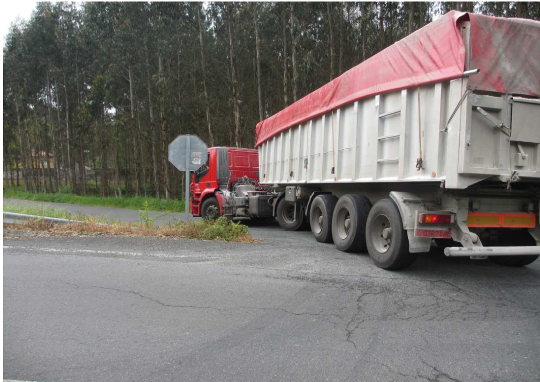
Figura 5: Insuficiencia de sección para el giro de vehículos pesados en la intersección siendo necesario la ocupación del carril contrario (fuente propia)
