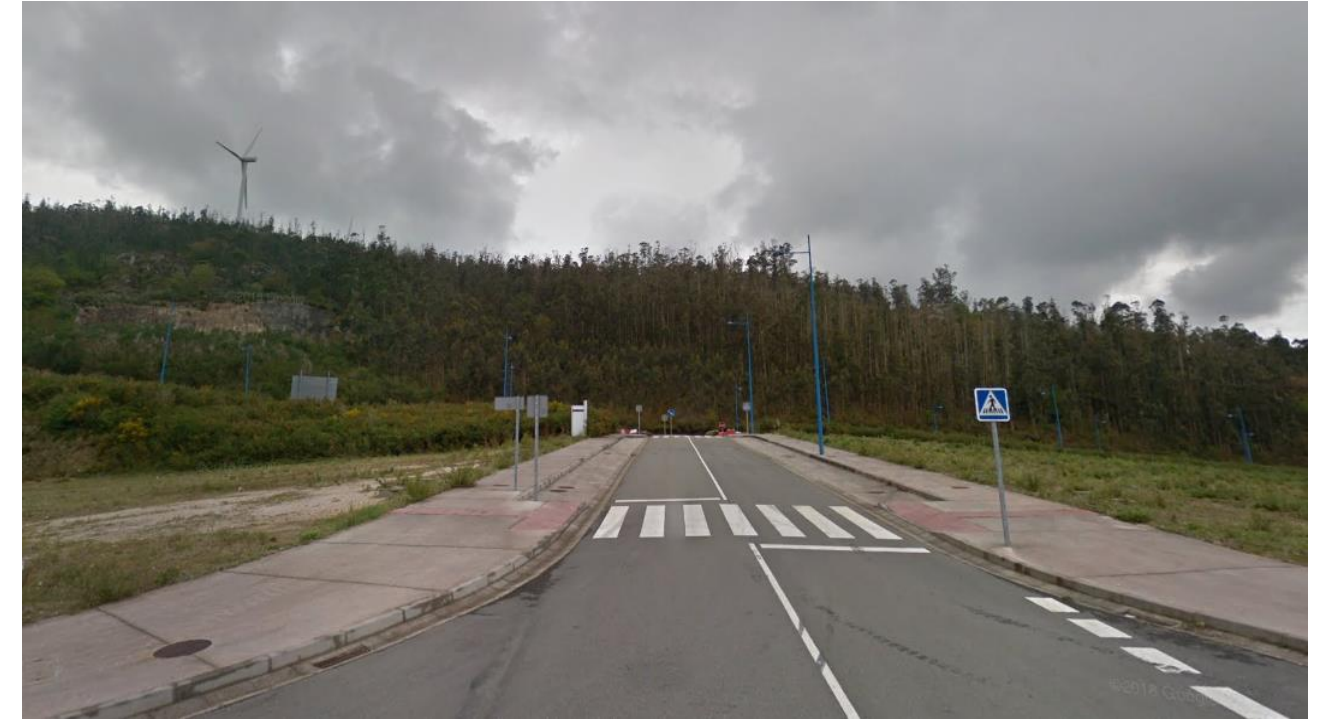
Fotografía 9. Salida del polígono industrial de Vimianzo a la AC-552
