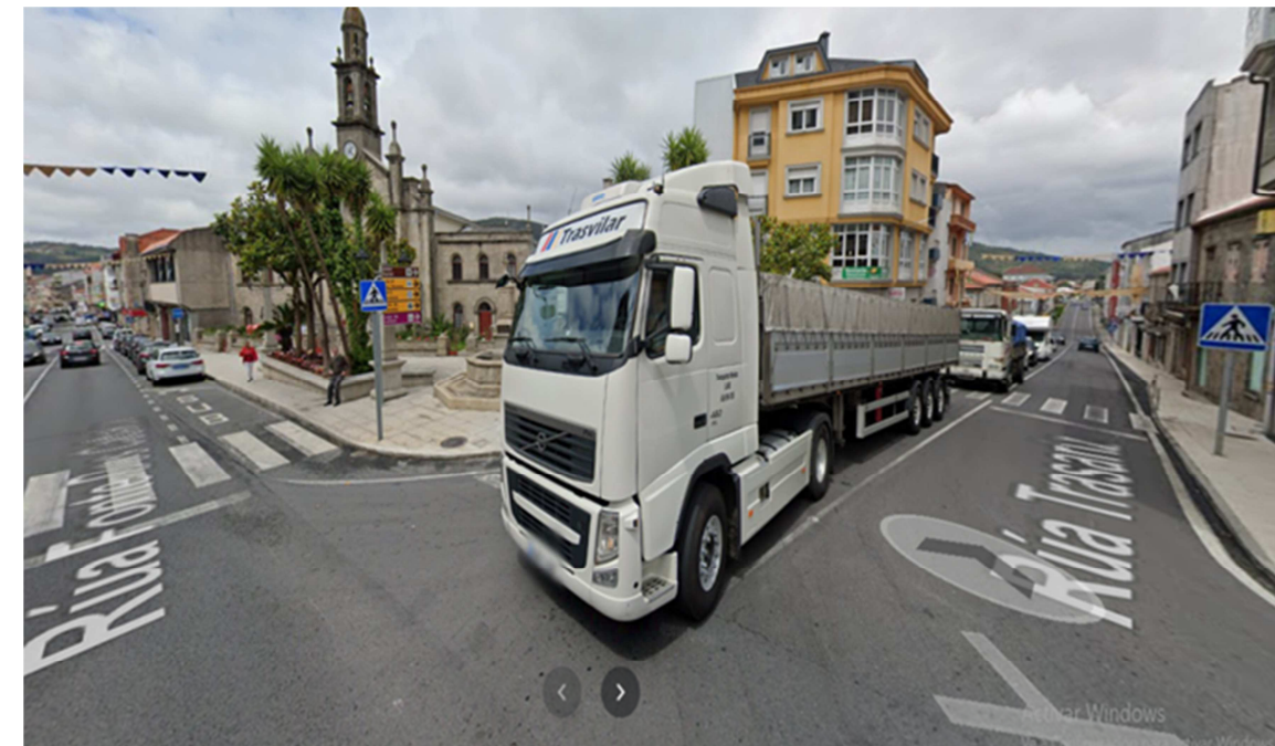
Figura 4: Circulación de tráfico pesado por el núcleo urbano. Deterioro del firme. Intersección con AC-552 con elevado nivel de tráfico y nula visibilidad provocando retenciones
