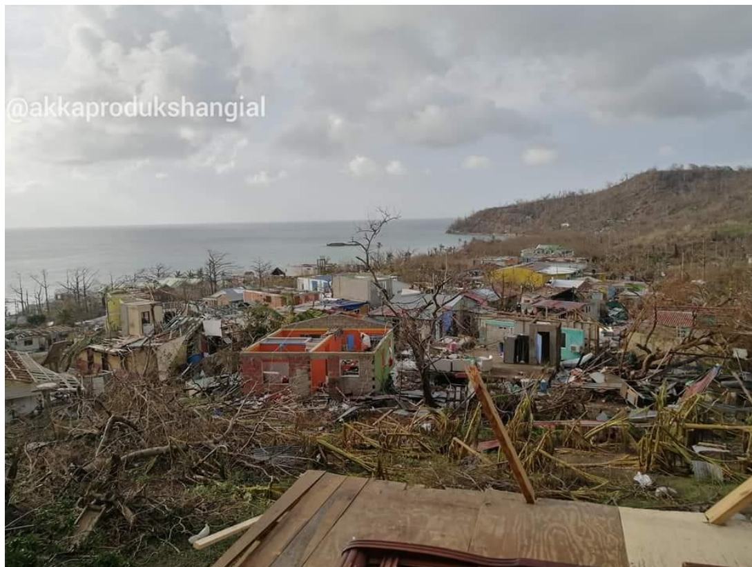
Figura 14 Afectación del sector de South West Bay después del paso del huracán Iota.
