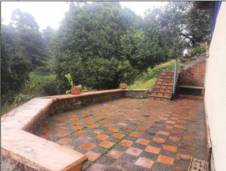
Fotografía 11. Terraza planta baja
