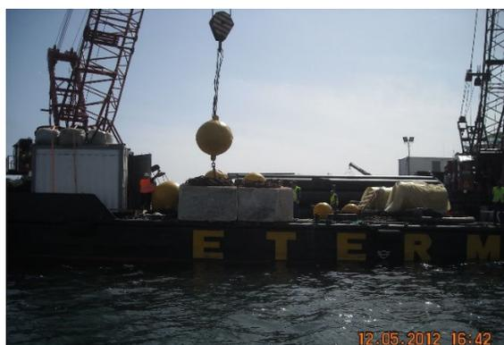
Figura nº 50 – Colocação de amarrações nas tubagens usando poitas de 12 tons.
