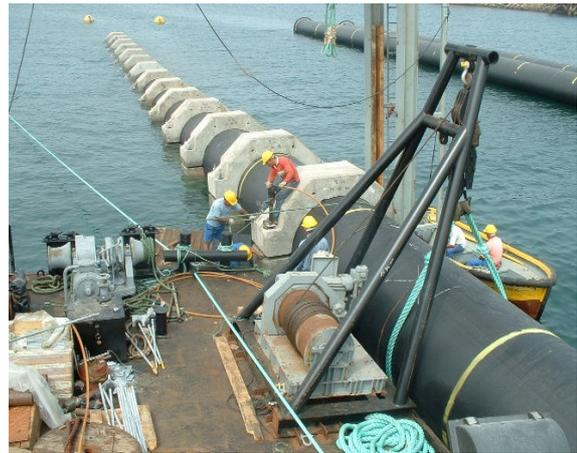
Figura nº 54 – Aperto dos anéis com equipamentos pneumáticos.
