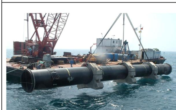
Figura nº 72 – Colocação do troço na água.
