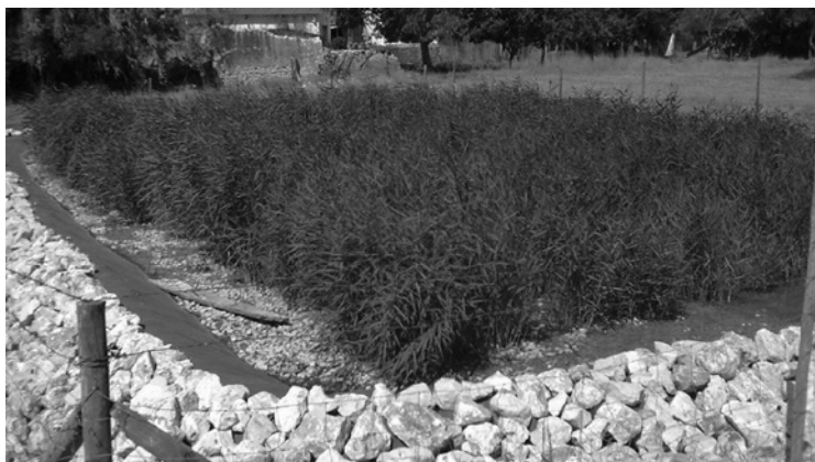
Figura 4 – Fotografia de ZHC de tratamento secundário de um pequeno agregado residencial (Em Tomar, Portugal).
