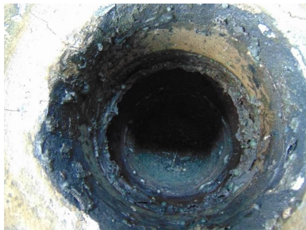
Figura 35 - Cadinho após primeiro dia de vazamentos
