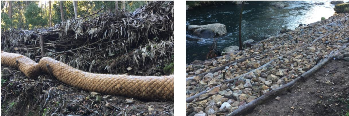
Fig. Biorolo vegetado (esquerda) e Enrocamento vivo (direita) - Raquel Castro 14.01.21
