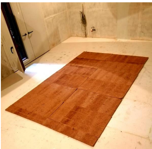
B 7 e 8 – Montagem das camadas de fibra de coco e aglomerado negro de cortiça.
