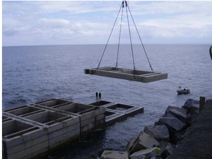
Figura 26 – Colocação das células de betão prefabricadas (Torre-Enciso et al. , 2009).
