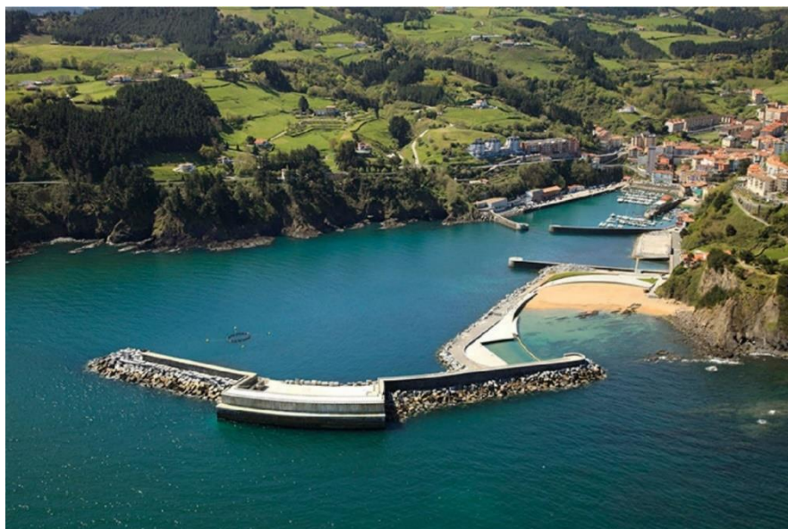
Figura 23 – Quebramar exterior com a coluna de água oscilante no centro (primeiro plano) e porto (segundo plano) (Henriques e Falcao, 2017).
