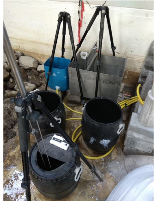
Figura 81 – Saída das condutas flexíveis dos reservatórios do SSG (esquerda) e ligação aos reservatórios auxiliares (direita).
