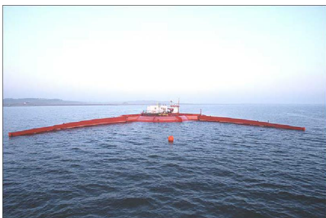
Figura 36 – Protótipo do Wave Dragon instalado na Dinamarca (esquerda) e princípio de funcionamento (direita) (Wave Dragon, 2018).
