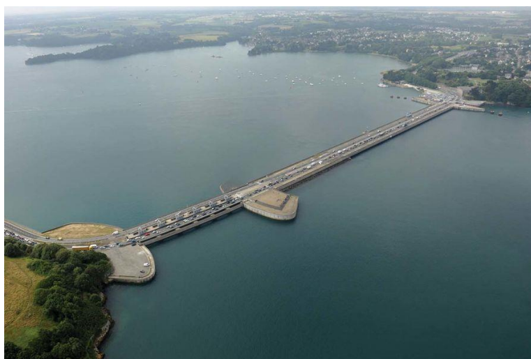
Figura 16 – Usine Marémotrice de la Rance, na Bretanha (L'Usine Nouvelle, 2017).
