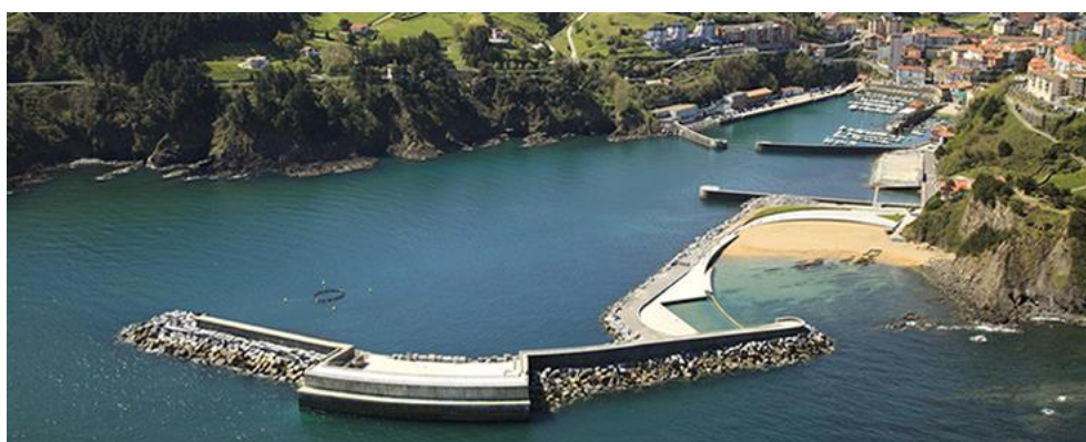
Figura 6 – CAO integrado no quebramar do porto de Mutriku, Espanha (Ente Vasco de la Energia, 2017).
