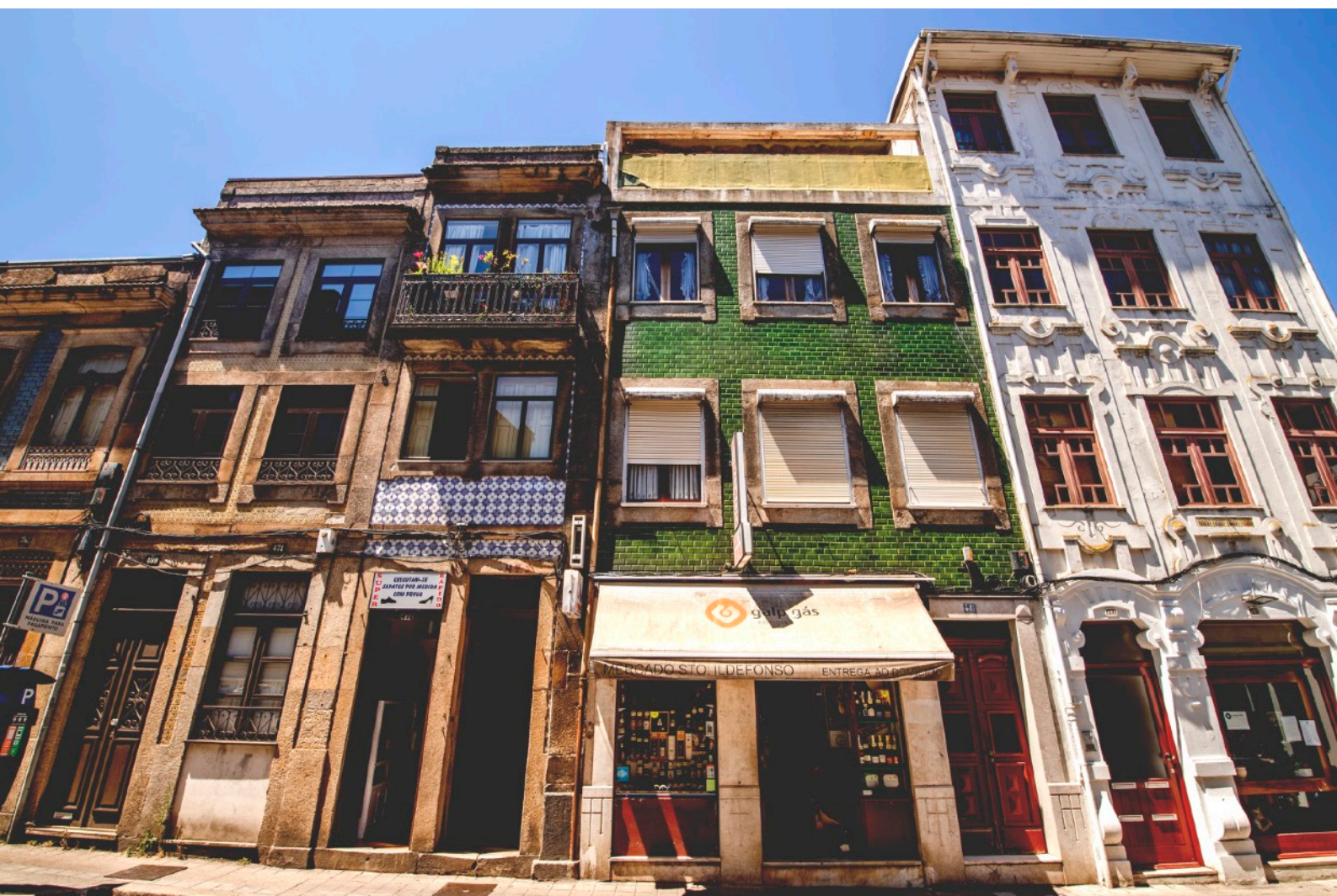
Rua de Santo Ildefonso: edifícios geminados com comércio no rés do chão e apartamentos em cima
