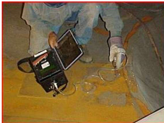
Figura 21– Medição da explosividade entre o fundo do tanque e a base de assentamento através da abertura criada para o efeito
