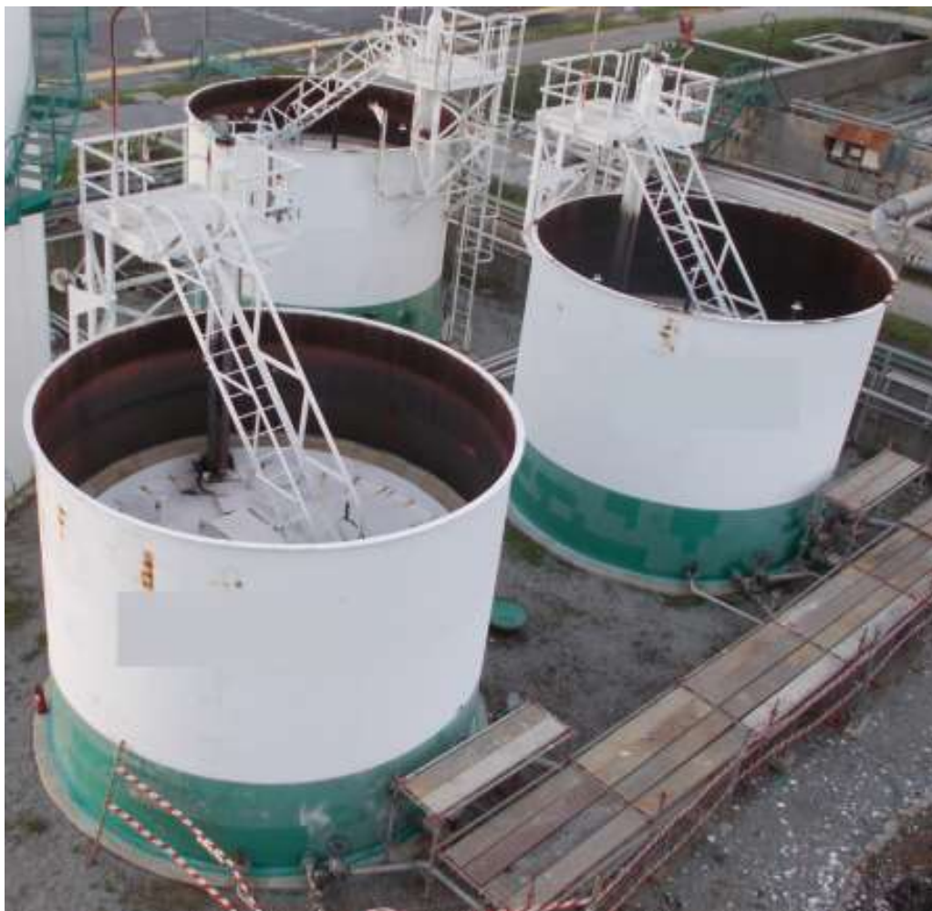
Figura 5-Tanques de Gasolina- Teto Flutuante contacto directo com a atmosfera
