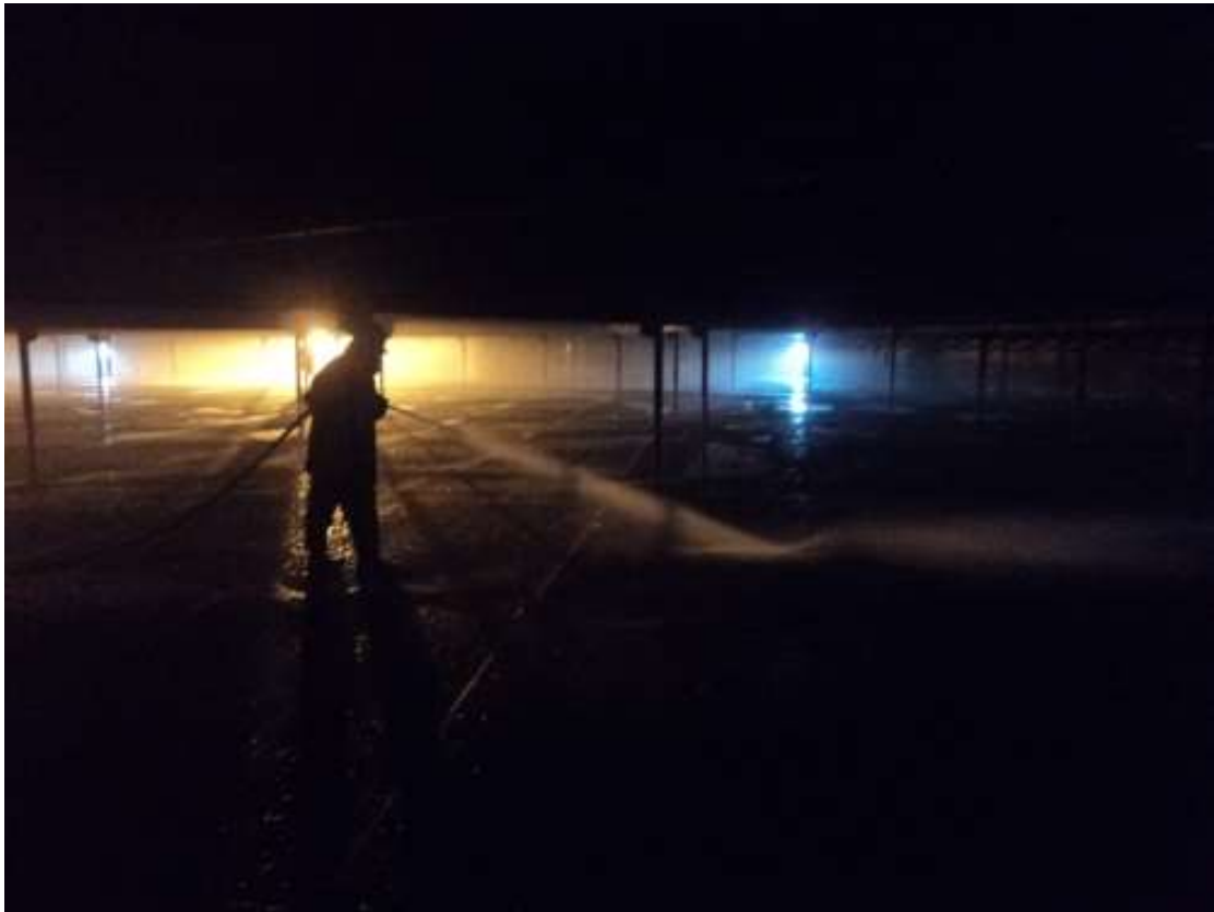
Figura 27- Limpeza manual do fundo do tanque a jacto de água
