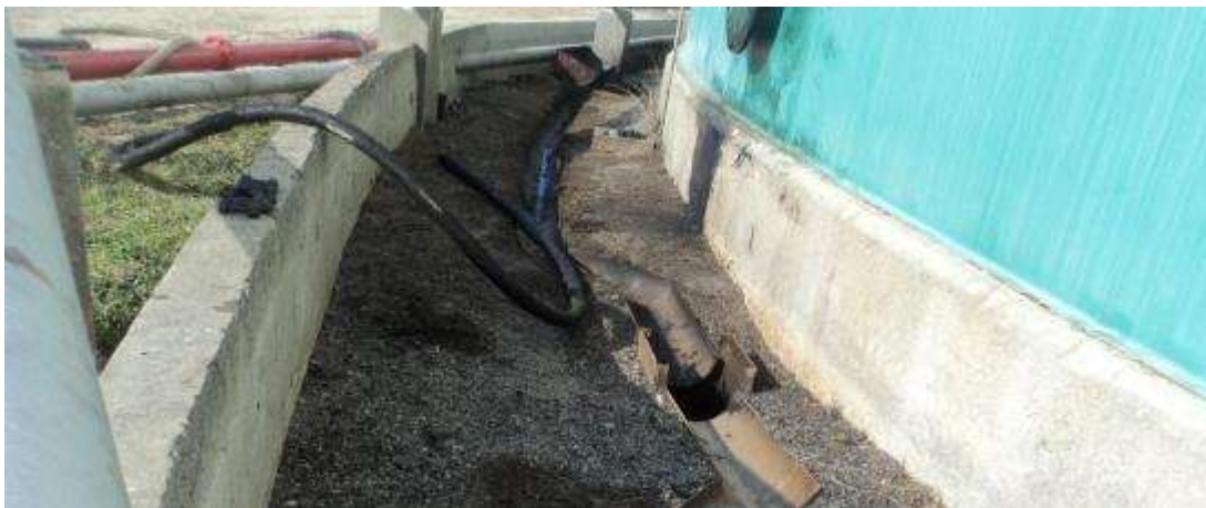
Figura 15- Dique para utilização em “reparações maiores”
