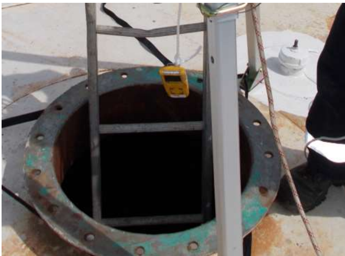
Figura 22- Monitorização da atmosfera no interior do tanque, eventual presença de sulfureto de hidrogénio (H 2 S)
