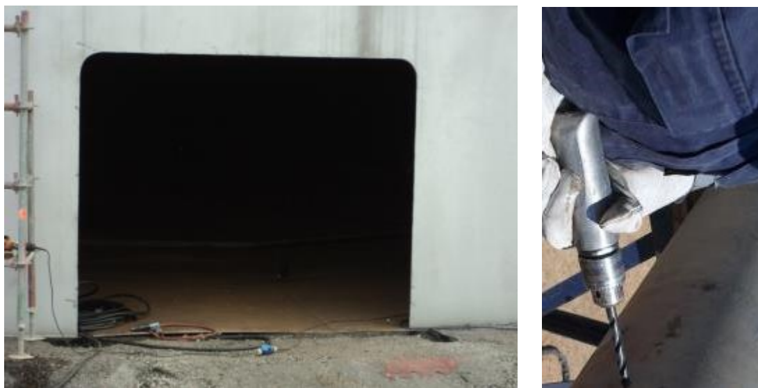
Figura 11- Utilização da máquina de furar pneumática com a abertura do furo
