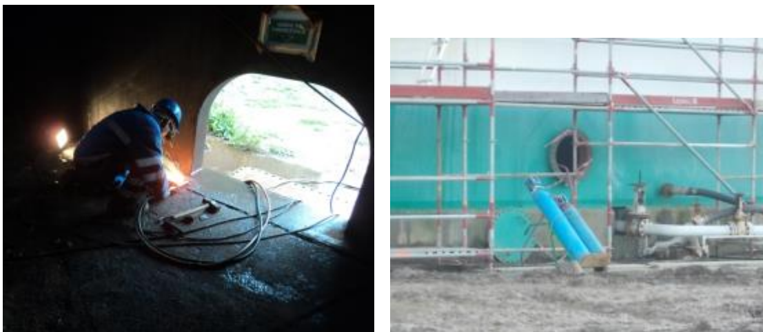
Figura 25- Trabalho interior de oxicorte no fundo do tanque e garrafas no exterior
