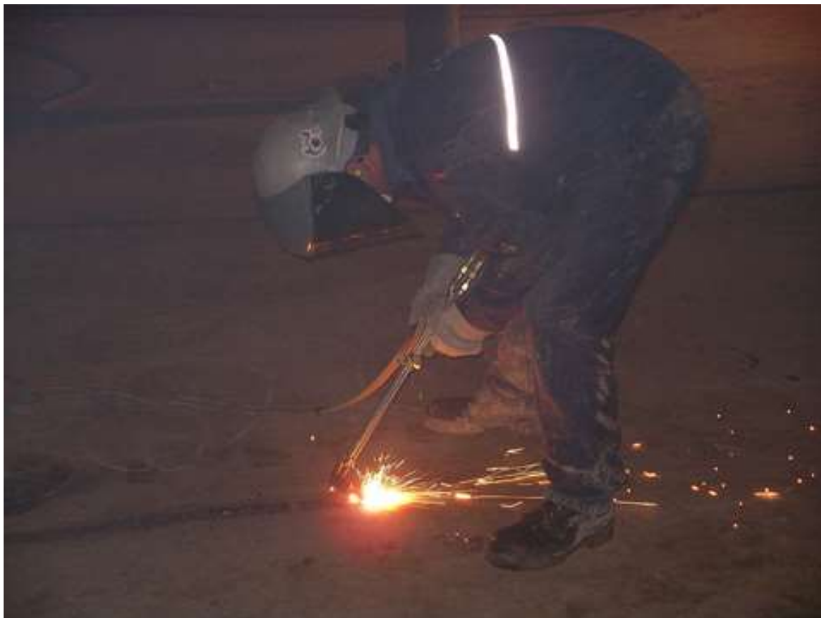
Figura 7– Corte a quente/fogos nus-utilização do oxicorte para remover a chapa do fundo do tanque
