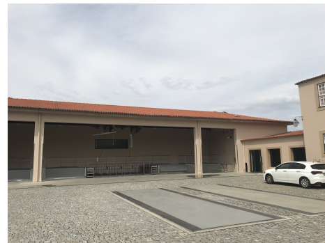
(d) Building Left View
