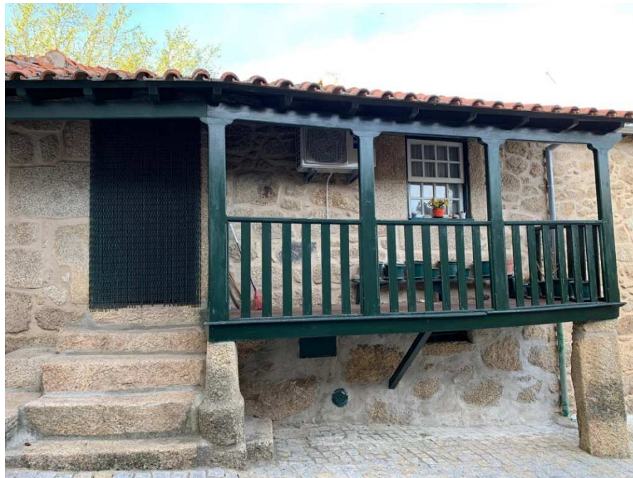
Fig. 4.19 – Varanda da habitação
