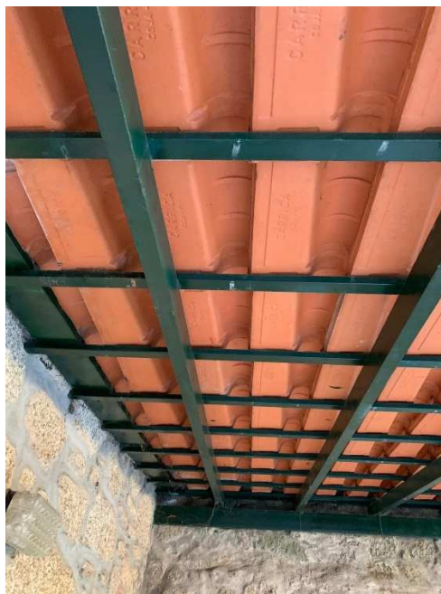
Fig. 5.3 – Estrutura do alpendre
