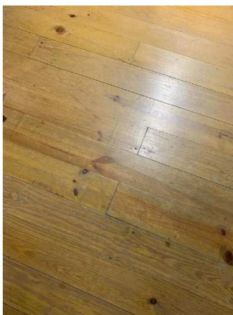
Fig. 4.12 – Pavimento do piso 1
