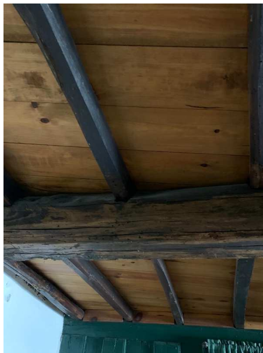
Fig. 5.6 – Estrutura do teto da sala
