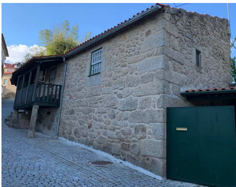
Fig. 4.10 – Parede exterior do edifício
