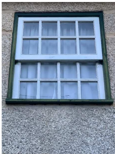
Fig. 4.16 – Janela na frente do edifício
