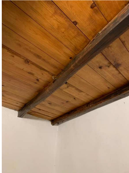
Fig. 4.15 – Teto do piso 1
