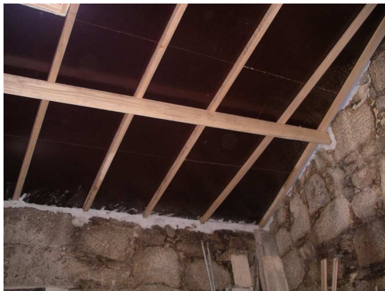
Fig. 5.10 – Cobertura da casa 4
