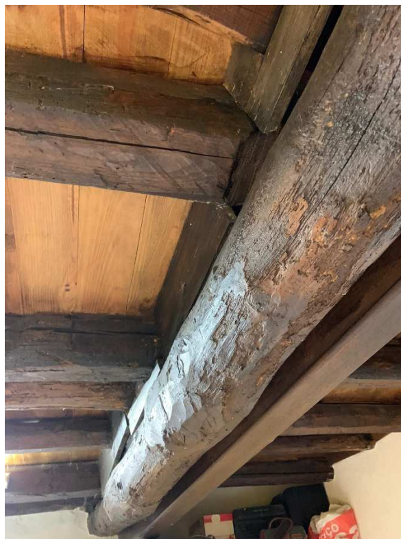
Fig. 5.2 – Estrutura do piso 1 (pormenor da viga principal)
