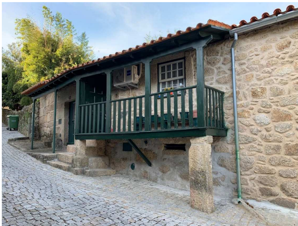
Fig. 4.2 – Perspetiva da Rua de Santana, com o edifício em estudo
