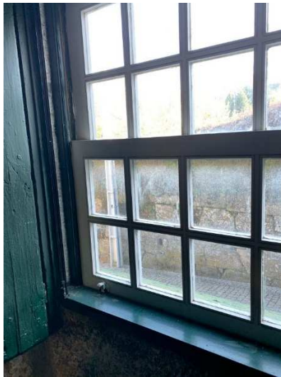
Fig. 4.22 – Pormenor da caixilharia exterior
