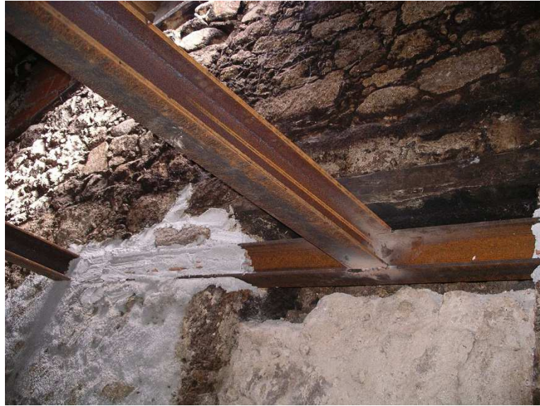
Fig. 5.8 – Vigas metálicas no espaço 4 (fotografia da estrutura aquando das obras de 2007)
