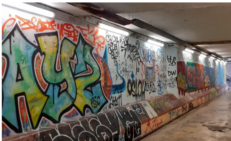
6 Passagem pedonal subterrânea da Estação Alcântara Mar. Lisboa.
