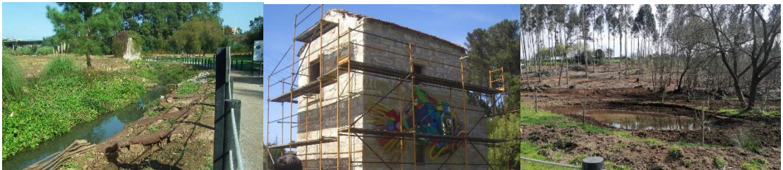
Figura 3.24 – Resultado da formalização do Trilho Ecológico da LIPOR, após a construção do Laboratório de Rios+, no ano 2017, a recuperação do antigo moinho, no ano 2018, e a renaturalização do espaço envolvente, com soluções naturais de drenagem pluvial, no ano 2021 (Autor: Diana Fernandes)
