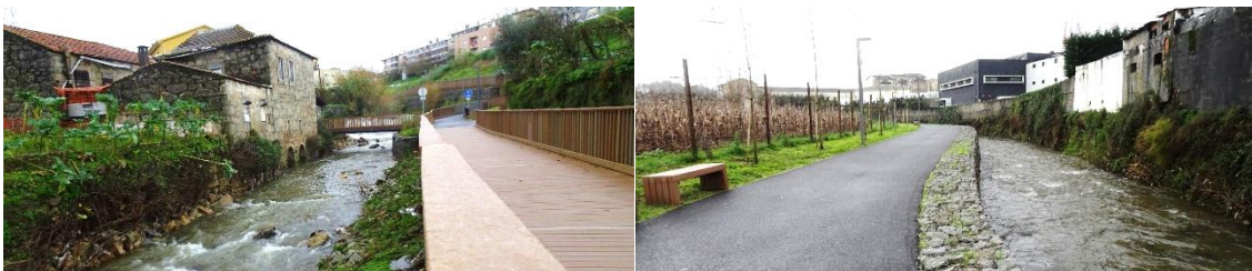
Figura 3.27 – Resultado da construção do Intercetor de Rio Tinto e do passadiço, que liga o Parque Urbano de Rio Tinto ao Parque Oriental da Cidade do Porto, registado no ano 2019 (Autor: Diana Fernandes)
