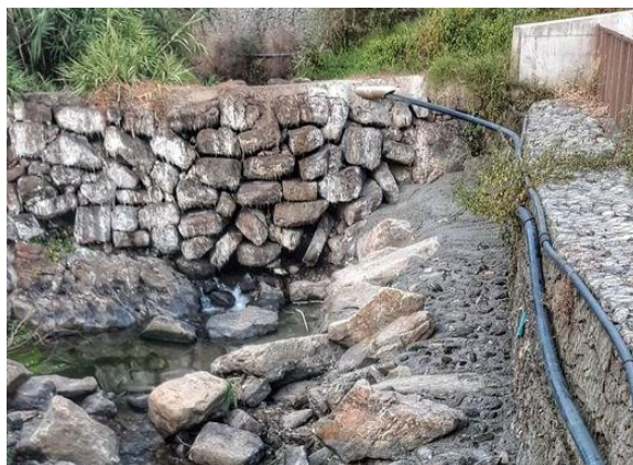
Figura 3.28 – Pormenor do muro de gabião com base cimentada, registado no ano 2020 (Fonte: https://www.facebook.com/MovimentoEmDefesaDoRioTinto/ )
