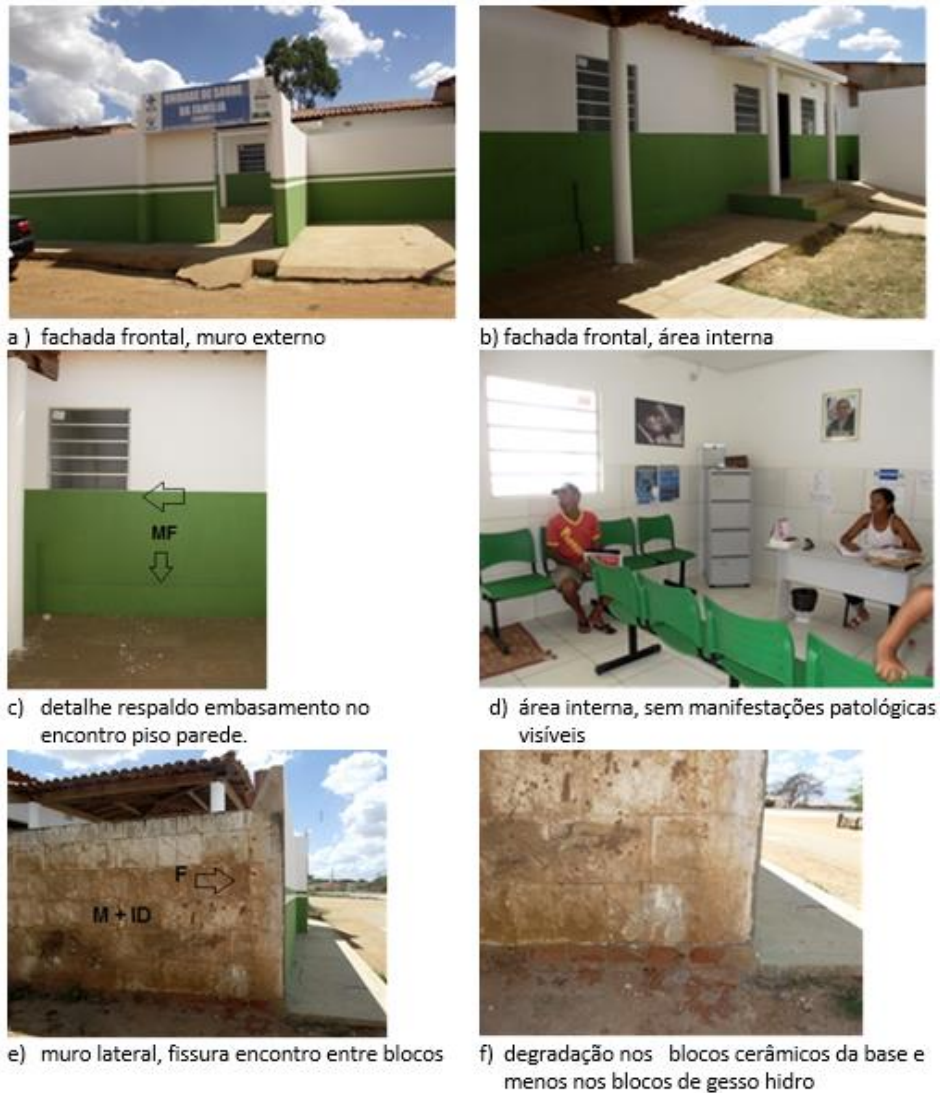
Figura 138- Amostra 12- detalhes das manifestações patológicas
