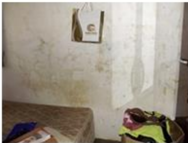
c) parede lateral direita- diminuição de manchas de umidade entre os anos, as manchas mostram que as infiltrações são superiores nos blocos standard, sem no entanto mostrar fissuras ou destacamentos.
