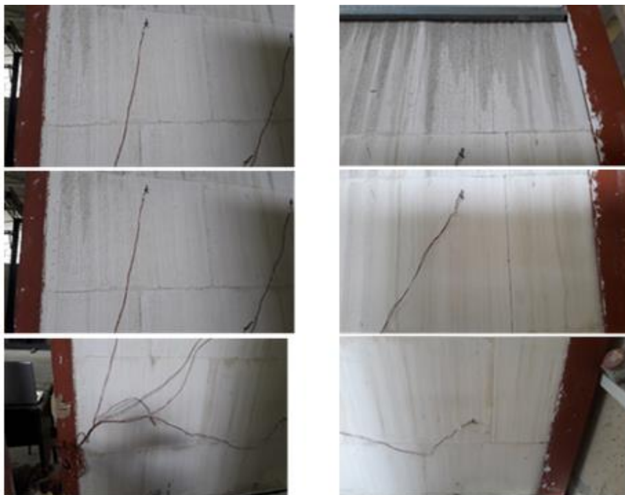
Figura 48-Aspectos da face exposta após a conclusão do 10ºciclo
