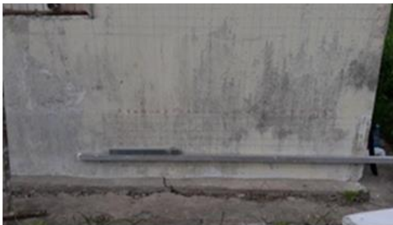
Figura 114-Trecho de parede de primeira fiada na face Oeste-Noroeste(blocos hidro)
