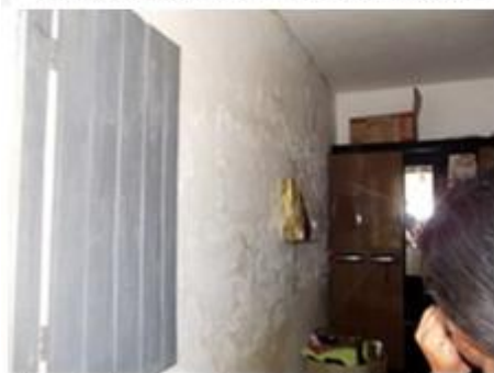
e) manchas e indicativos de perda de massa parede interna, sobre blocos standard
