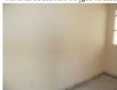
f) parede entre sala e quarto1, sem patologia aparente
