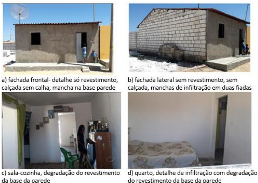
Figura 140-Amostra 14 - detalhe das manifestações patológicas
