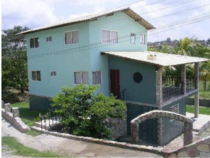
Figura 152-Amostra 21-aspectos da casa concluída e em uso no Condomínio N.S.do Carmo
