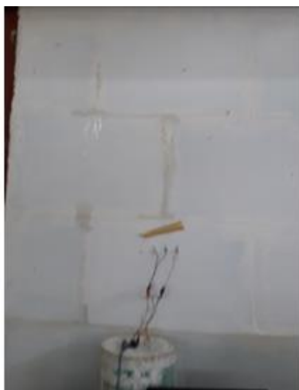
Figura 54-Colocação de fita adesiva para direcionar água infiltrada pela junta
