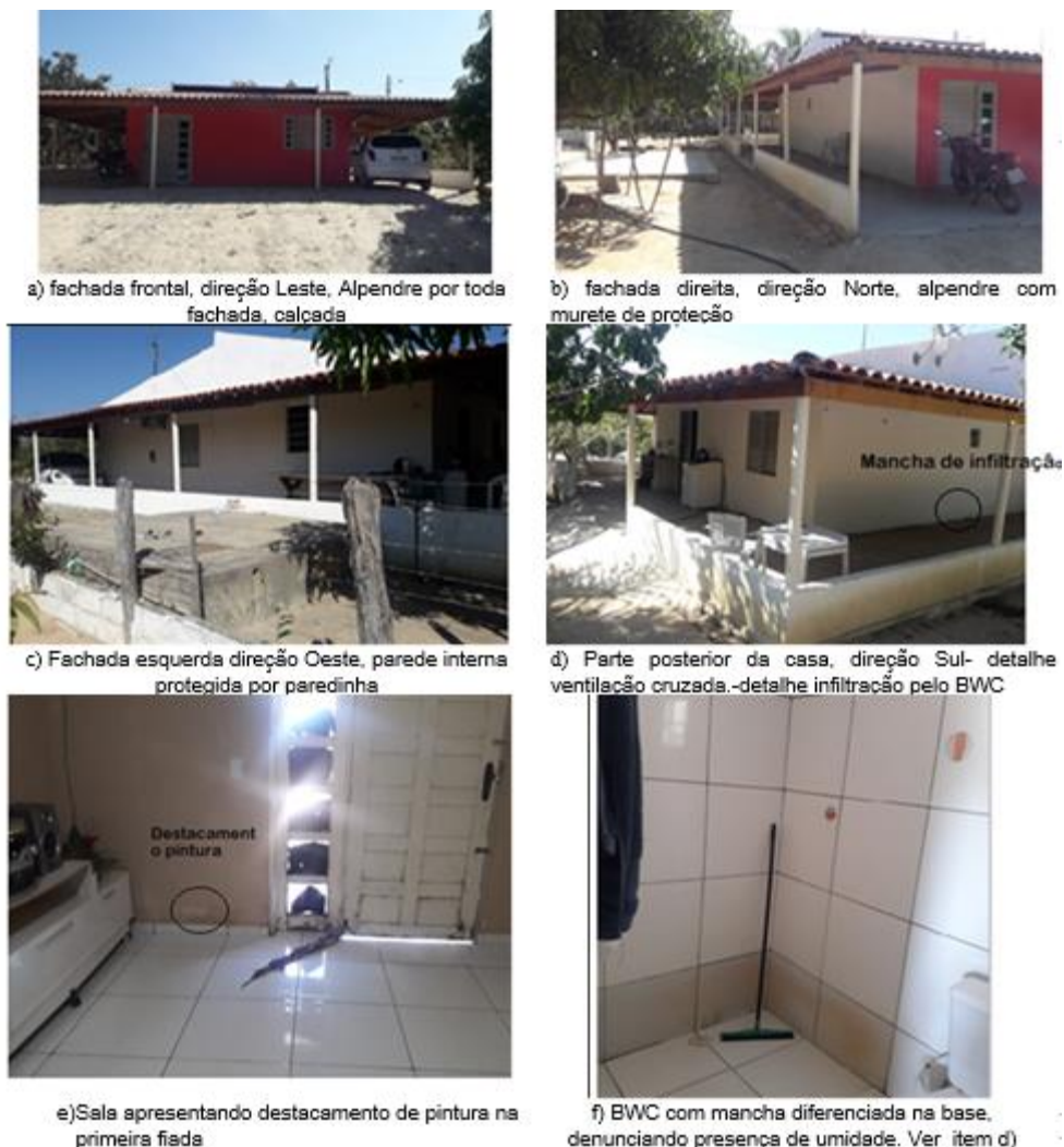
Figura 131-Amostra 7- detalhes das manifestações patológicas
