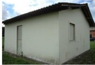
b)fachada posterior(FP) e FLD- vista geral
