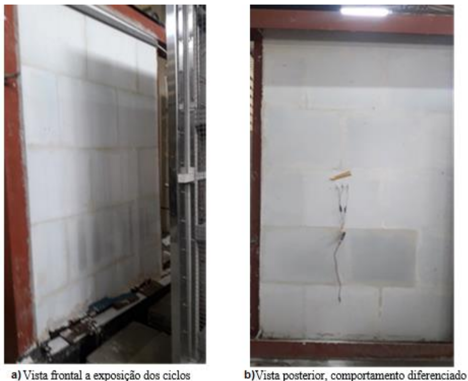
Figura 50-Aspecto dos blocos que compõe a parede, considerados hidro
