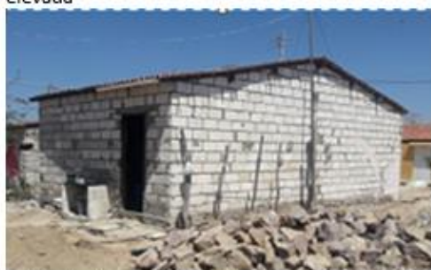
c) fachadas posterior e lateral, sem revestimentos, verga sobre porta
