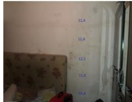
c) face interna parede da lateral- em 2017 mostra mais sinais de manchas de umidade que em 2018, as manchas mostram que as infiltrações são superiores nos blocos standard.
