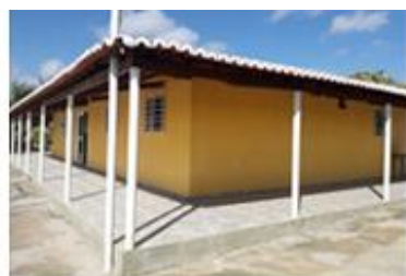
a) fachada esquerda, direção Sudoeste-SW, base da parede protegida por rodapé
