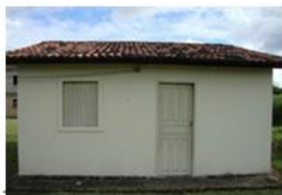
a) Fachada frontal (FF-NE) – vista geral
