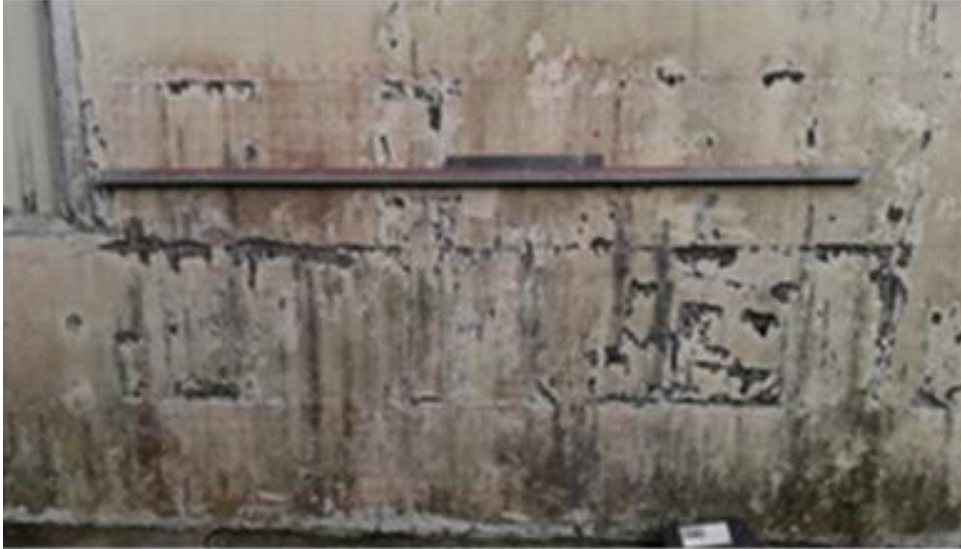
Figura 108-Trecho da parede Este-Sudeste do protótipo-régua na segunda fiada(blocos standard)
