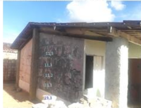
b) fachada lateral direita- mostra pouco crescimento das degradações entre os registros de 2017 e 2018.
