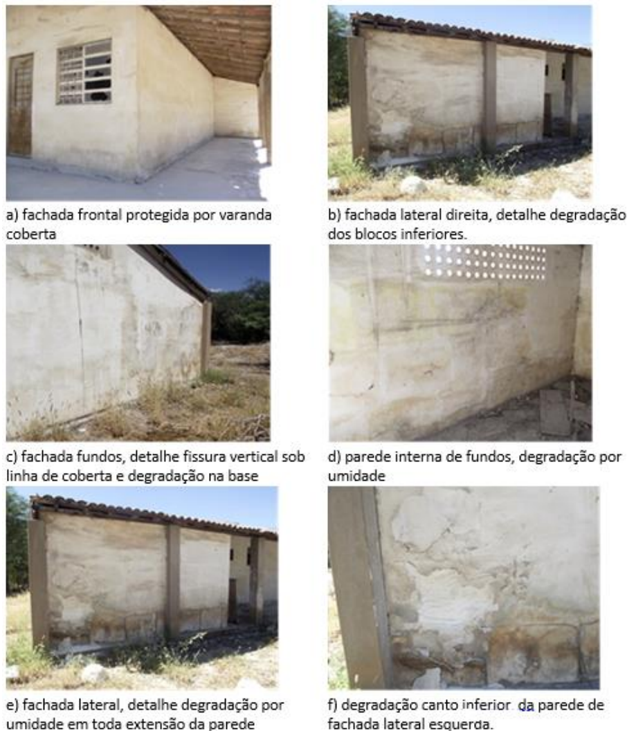
Figura 139-Amostra 13- detalhe das manifestações patológicas
