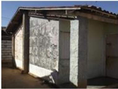
b) fachada lateral direita, direção nordeste, apesar da diferença de luminosidade, observa-se pouquíssimas diferenças entre as situações 2017 e 2018, umidade superior na primeira fiada, junto a base.
