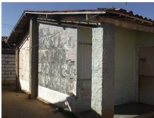
c) perda aderência pintura sobre blocos hidro e degradação em blocos standard
