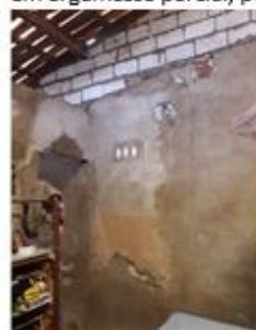
d) quarto com revestimento interior em argamassa, mostra retoques posteriores em várias etapas/momentos
