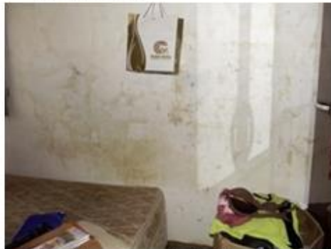
c) face interna parede da lateral- em 2017 mostra mais sinais de manchas de umidade que em 2018, as manchas mostram que as infiltrações são superiores nos blocos standard.
