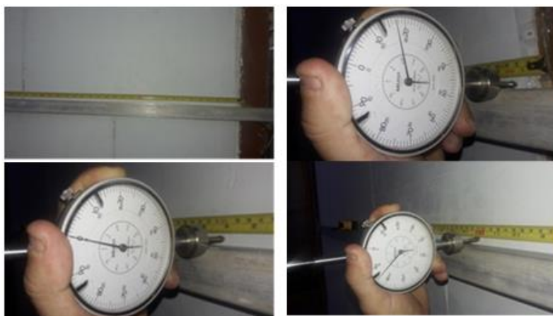
Figura 64-Aspectos de medição de desgaste superficial parede bloco hidro
