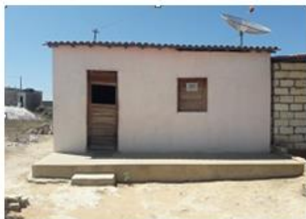
a) fachada frontal com revestimento pintado, sem indicativo de degradação, com calçada elevada
