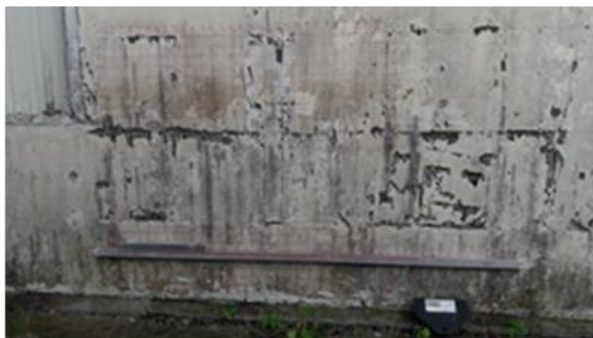
Figura 110- Trecho da parede Este-Sudeste- régua posicionada na primeira fiada(blocos hidro)
