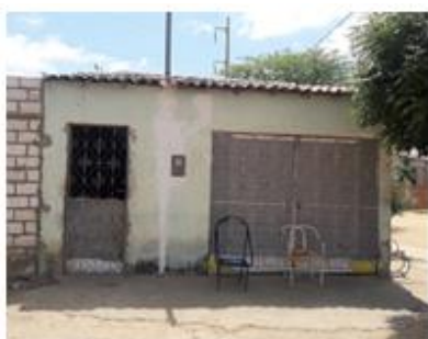
a) fachada frontal em argamassa de cimento e pintura à base de cal, degradação da pintura na base
