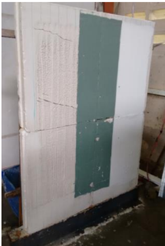
Figura 91- Aspecto da superfície exposta após o 12º ciclo
