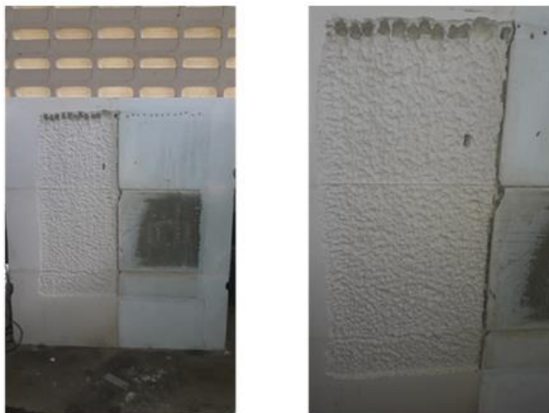
Figura 75- Aspectos da parede após 45 horas da ação do ensaio de estanqueidade-detelhe de parte bloco standard
