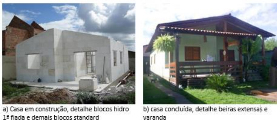
Figura 154 - Amostra 22 - aspectos construtivos e casa concluída no Conjunto Baviera em Gravatá-PE
