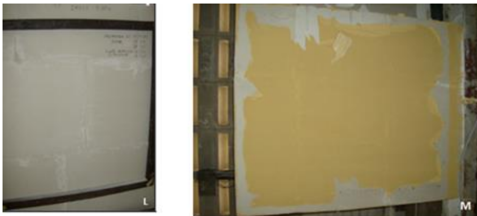
Figura 81-Teste de estanqueidade parede de blocos standard com fundo preparador e tinta latex
