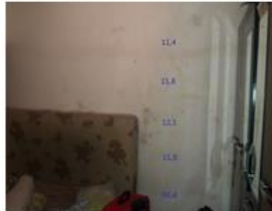
c) parede lateral direita- diminuição de manchas de umidade entre os anos, as manchas mostram que as infiltrações são superiores nos blocos standard, sem no entanto mostrar fissuras ou destacamentos.
