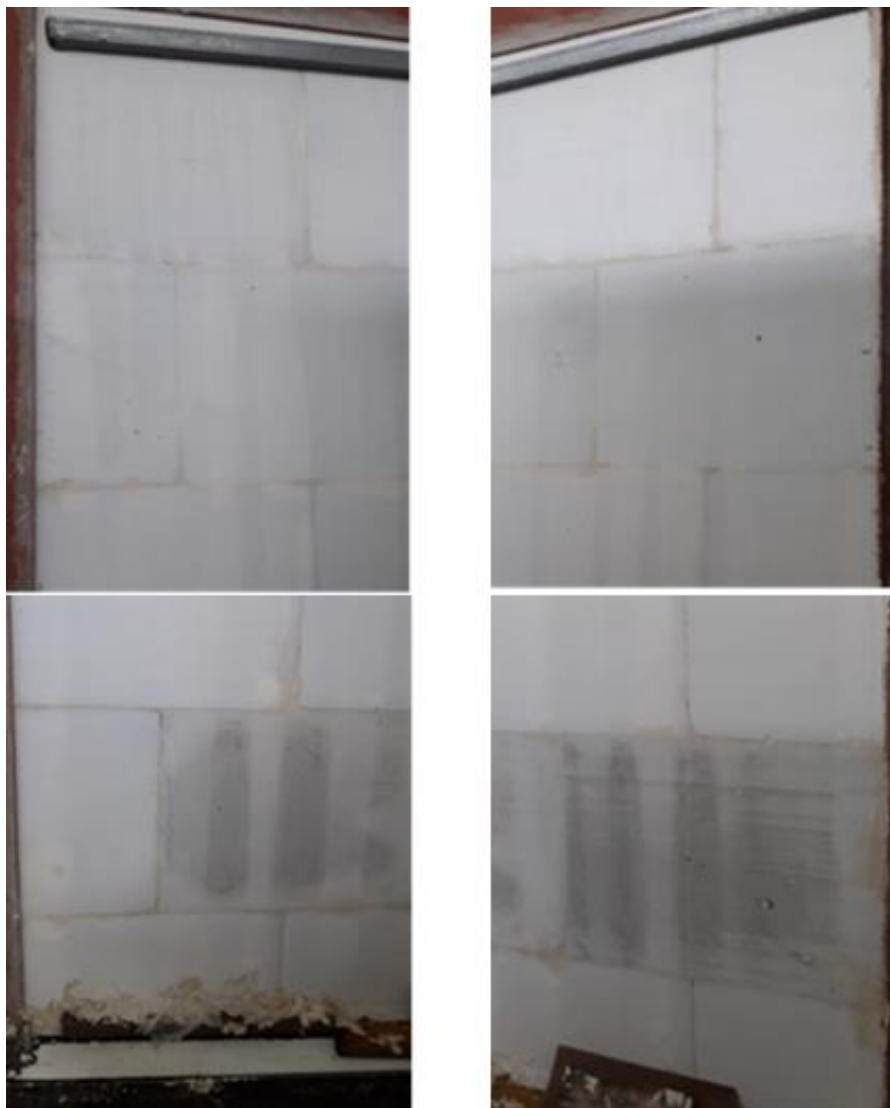
Figura 57-Aspectos da face exposta após ação do 5ºciclo
