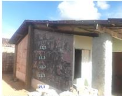
b) fachada lateral direita, direção nordeste, apesar da diferença de luminosidade, observa-se pouquíssimas diferenças entre as situações 2017 e 2018, umidade superior na primeira fiada, junto a base.
