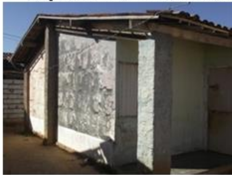
b) fachada lateral direita- mostra pouco crescimento das degradações entre os registros de 2017 e 2018.
