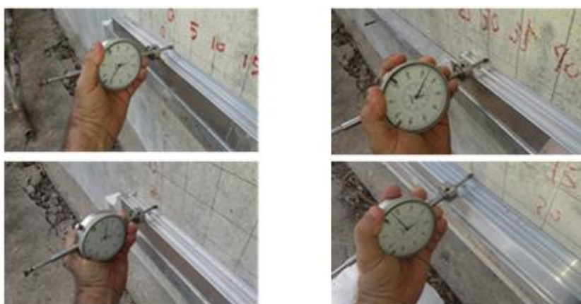
Figura 115-Medições realizadas no trecho de parede da primeira fiada(blocos hidro)
