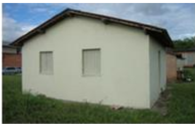
a) fachada Lateral Esquerda (FLE)(direção W)- vista geral
