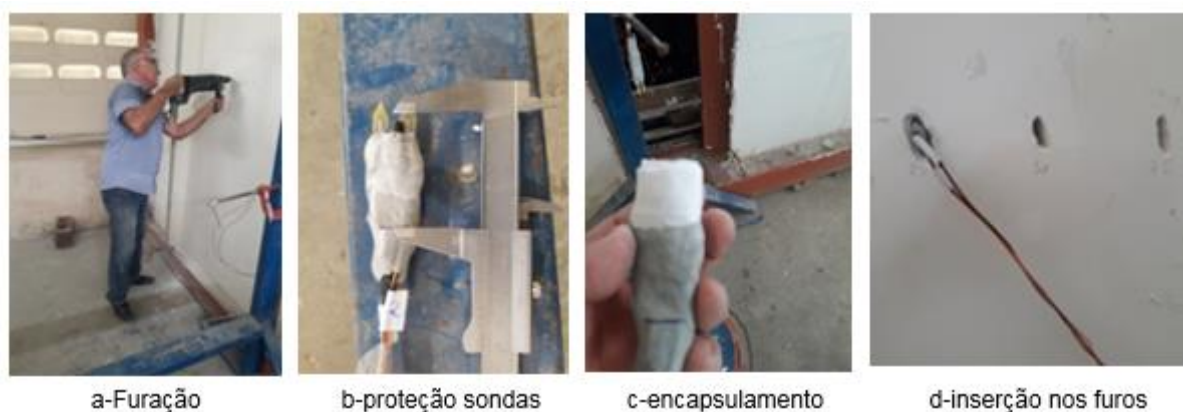
Figura 34-Procedimentos para inserção dos sensores na parede
