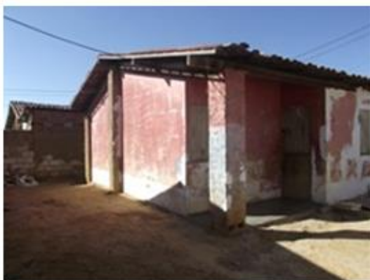
c) Fachada lateral, perda diferenciada 1ª fiada bem mais intensa
