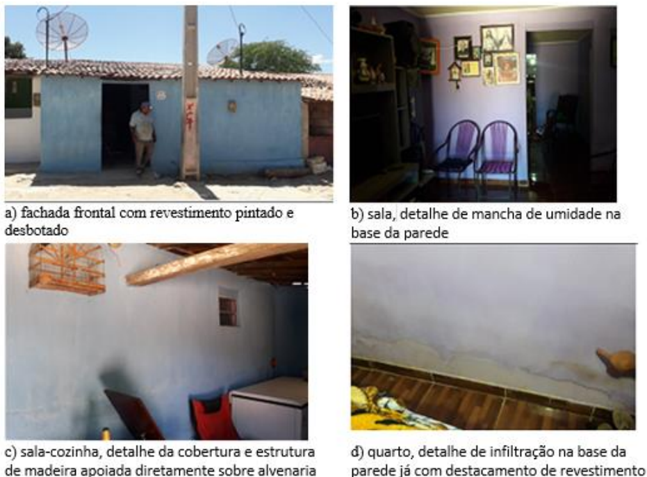
Figura 141-Amostra 15-detalle das manifestações patológicas
