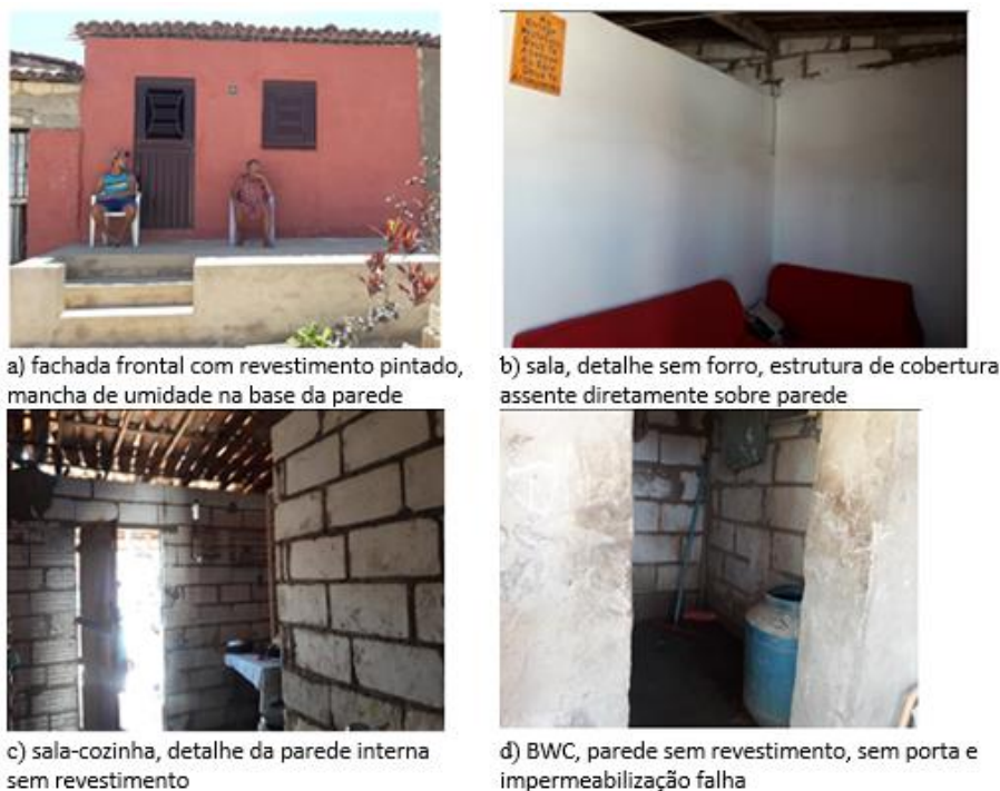
Figura 142-Amostra 16-detalle das manifestações patológicas
