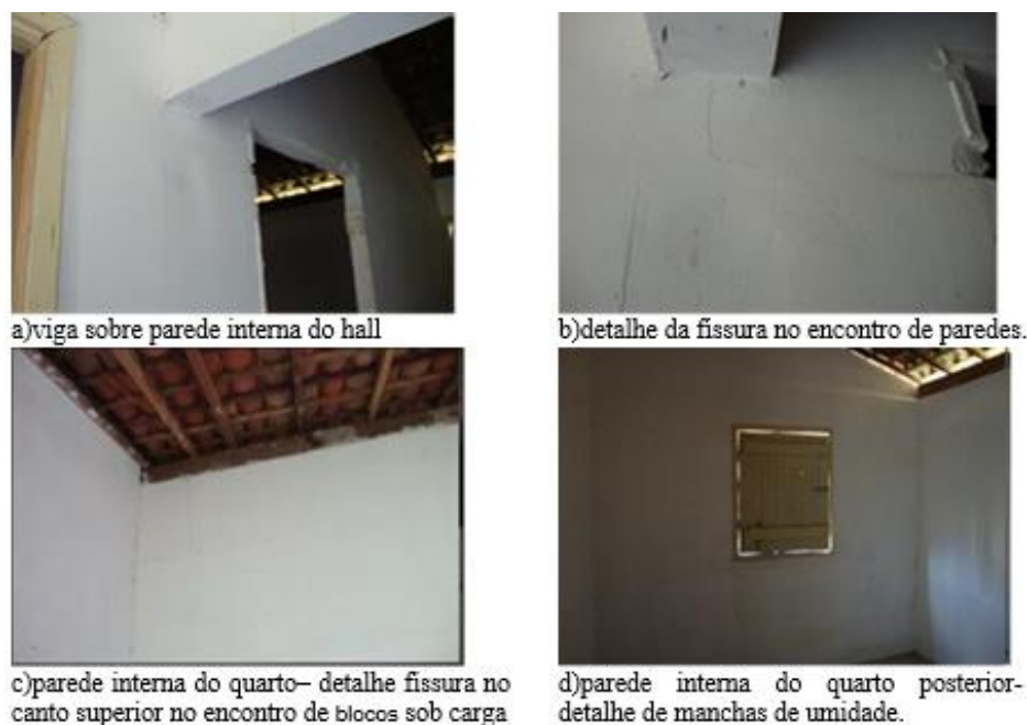
Figura 100- Manifestações patológicas no interior do protótipo
