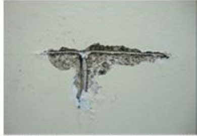
a)FLD- detalhe da degradação entre blocos da 2º e da 3º fiada- ambos blocos standard.
