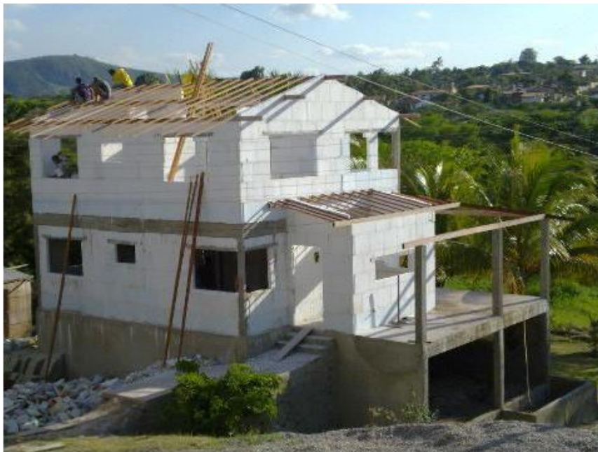
Figura 151-Amostra 21-aspectos construtivos de uma casa em alvenaria de blocos de gesso
