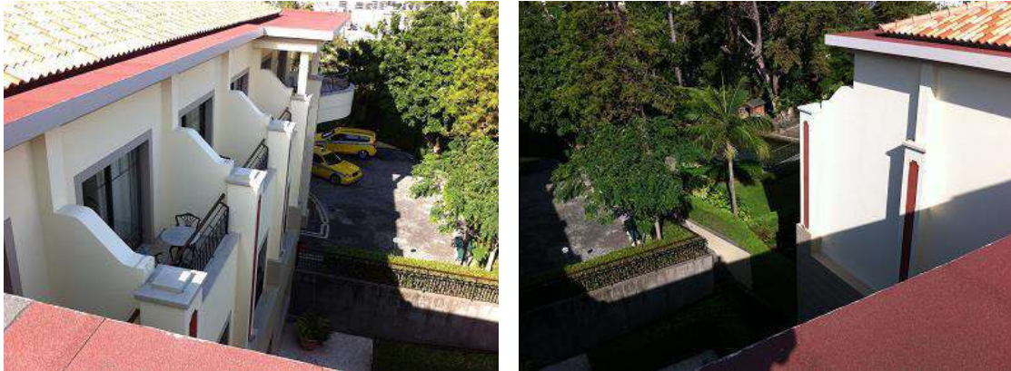
Figura 7 - Fotos gerais da envolvente vertical exterior do edifício
