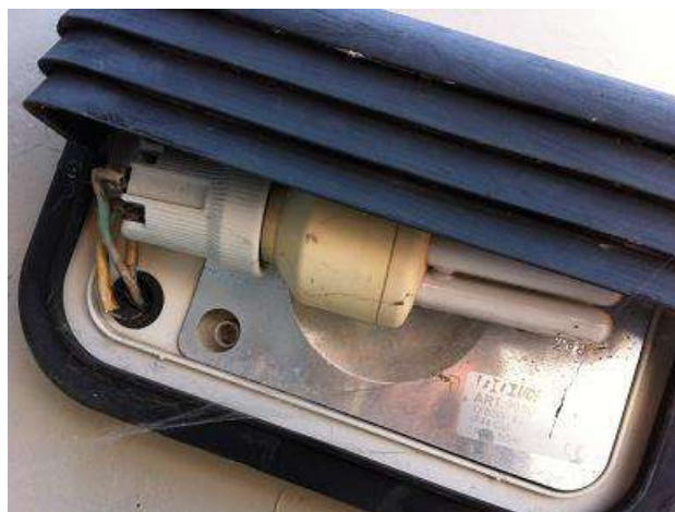
Figura 15 – Exemplo de iluminação exterior do edifício
