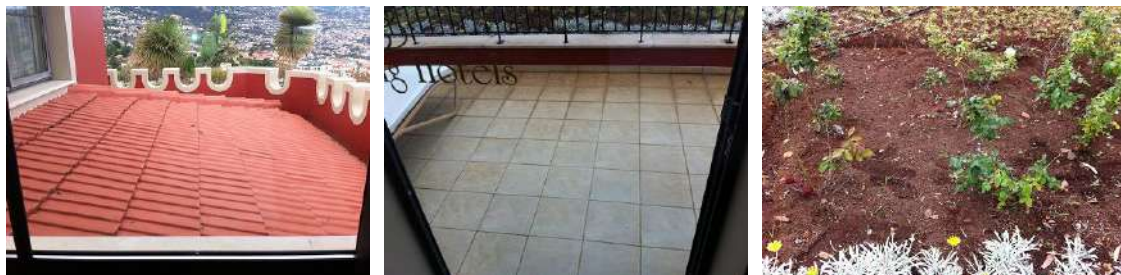
Figura 6 - Exemplos de coberturas exteriores do edifício
