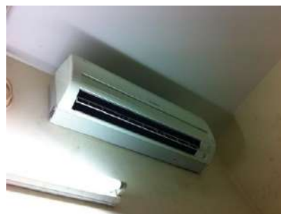
Figura 13 – Unidade interior do sistema split do bastidor
