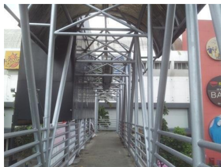
Gambar 1.6 Kondisi jembatan penyeberangan di area BIP.
