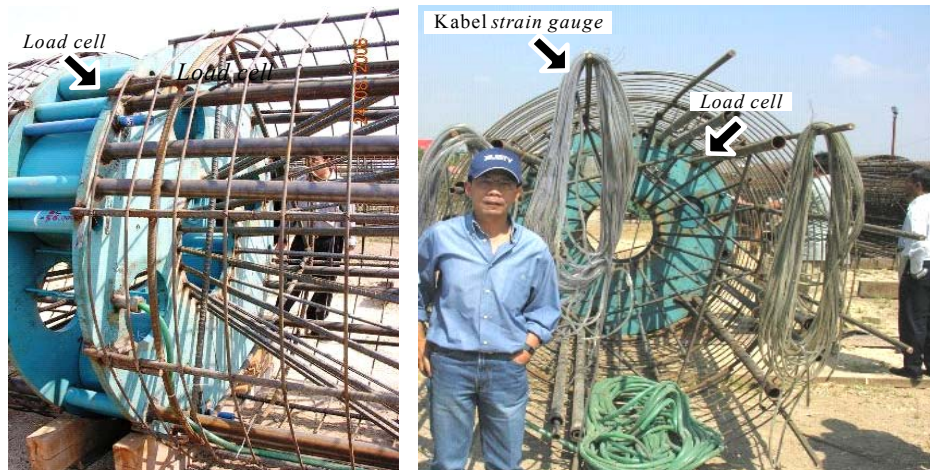
Gambar 9. Load cell yang dipasang pada reinforcement cage
