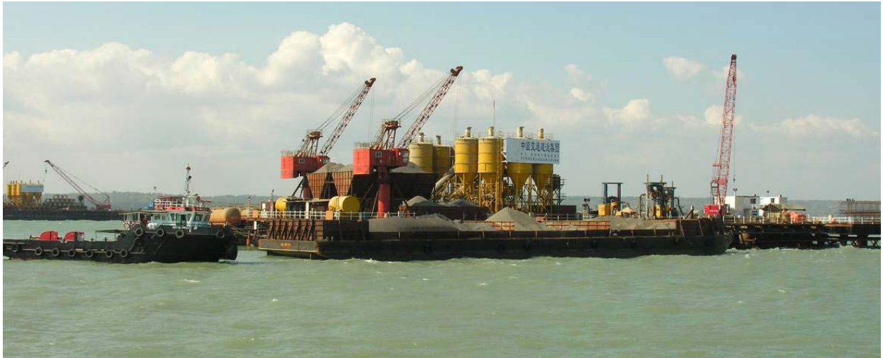
Gambar 2. Pelaksanaan pekerjaan pondasi tiang untuk jembatan utama
