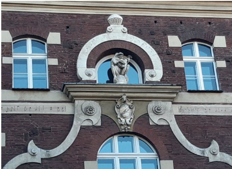
Fig. 2. The emblem identifying the "Pod Śpiewającą Żabą" ("Under a Singing Frog") tenement house at 1 Retoryka Street. Photo: W. Górny.
