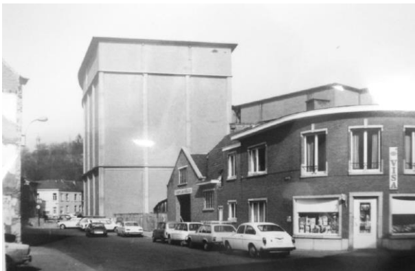
Figuur 25: Foto vanuit het zuiden van de oostzijde van de Mechelsestraat in de jaren zestig van vorige eeuw. (©Stedelijk Archief Leuven)
