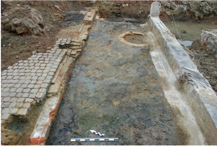
Figuur 28: Overzicht van werkput 1 vanuit het westen. (© agentschap Onroerend Erfgoed)
