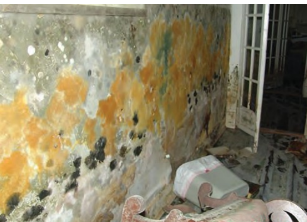
ハリケーン・カトリーナの被害の後、建物に発生したカビ(ニューオーリンズ)
