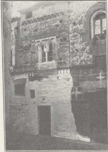
Casa mudéjar de ladrillo. (Cáceres.)
