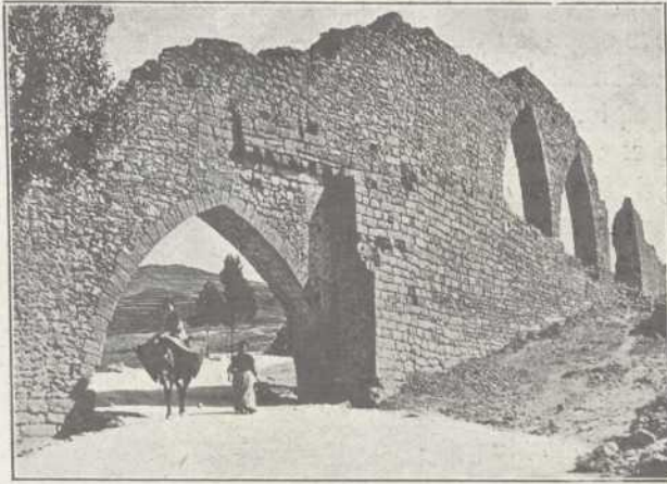
Acueducto. (Morella, Castellón.)
