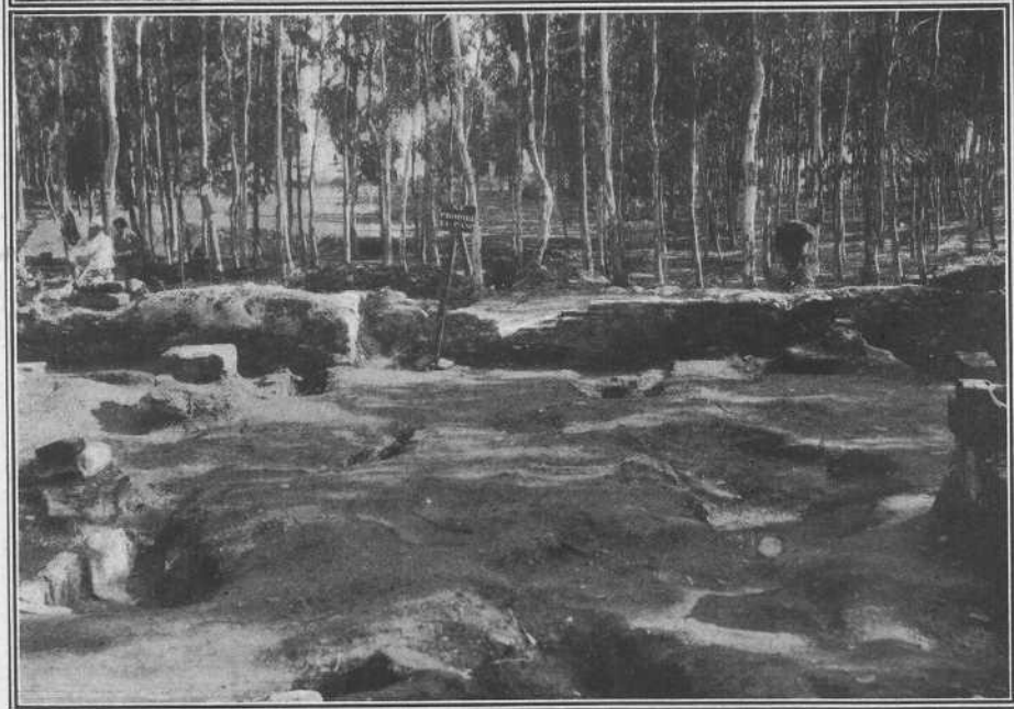
Basilica; frentes NE. y SE.
