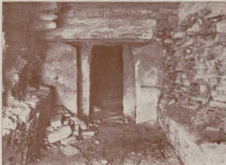
Romeral. Puerta de la Cámara
