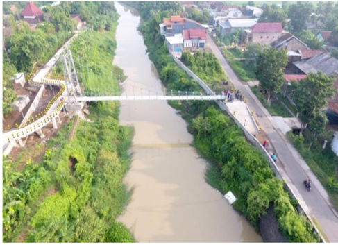
Gambar 4. Jembatan Gantung Sungai Gunting
