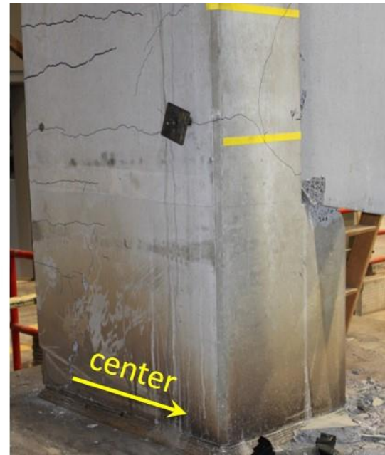
(d) Bottom-back inner-edge of right (west) end-column
