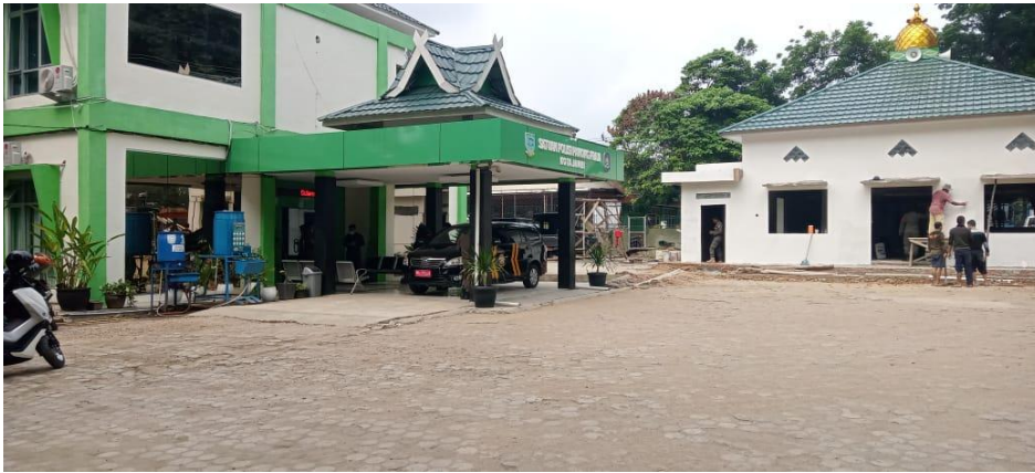
Kondisi Kantor Satpol PP Kota Jambi
