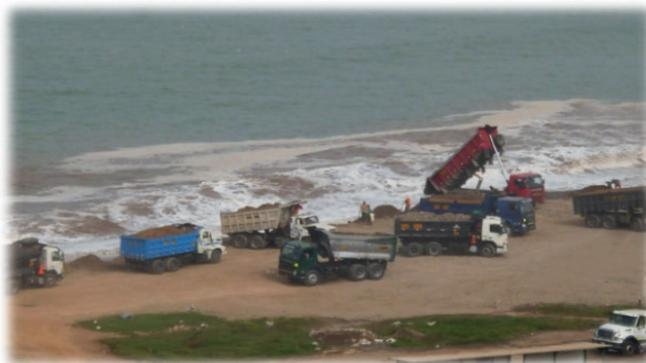
**Figura 1.** Descarga de residuos de demolición en Playas de San Miguel.
