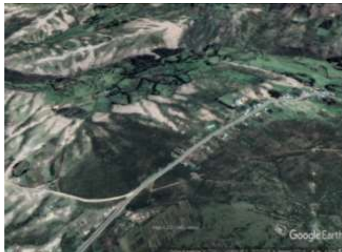
Figura 11: captura fotográfica del sector aprobado para el acondicionamiento urbano (desde desvío al oeste hacia el noreste) en el anexo San José de Chontaya, ubicado en el distrito de Pampachiri, provincia Andahuaylas, región Apurímac. Datos técnicos: fecha de imagen 17.04.2021. elevación 3700 msnm. Altura de ojo 4.29 Km. Coordenadas: 14°08'40.01" y 73°32'00.71". Fuente: Google earth 2021. Recuperado el 05.06.2021.
