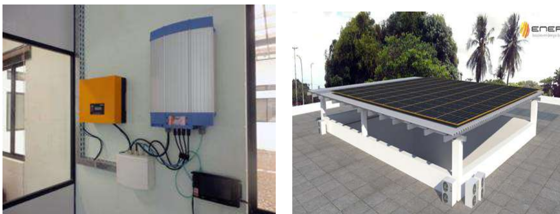
Figura 5 - Instalação do Sistema Solar no CENEA
