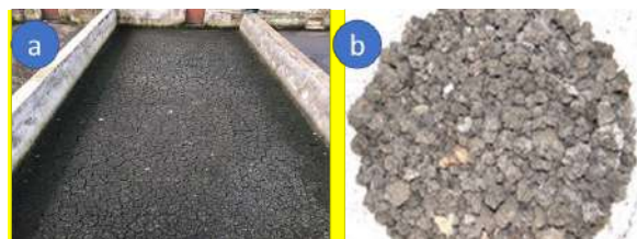
Figura 1 - Lodo da ETE: a) Leito de Secagem b) Lodo de Esgoto (Seco)
